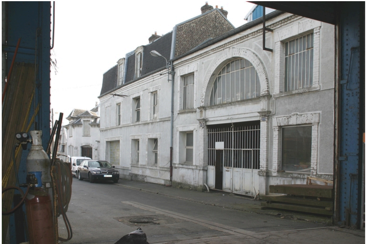
Façade antérieure des bureaux et de l'atelier des années 1920.
