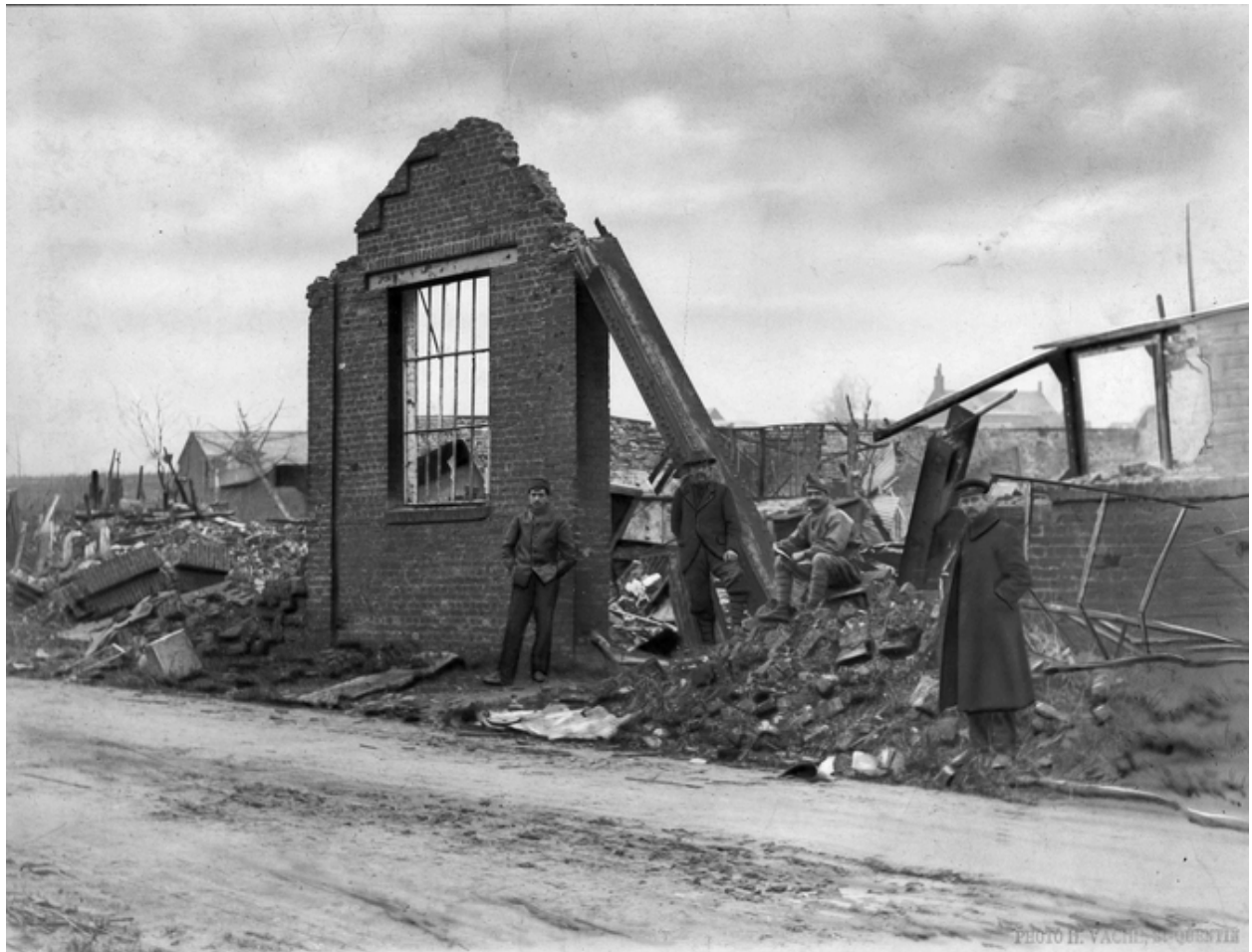
Les ruines des ateliers Bourleaux, vers 1919 (BM Saint-Quentin).
