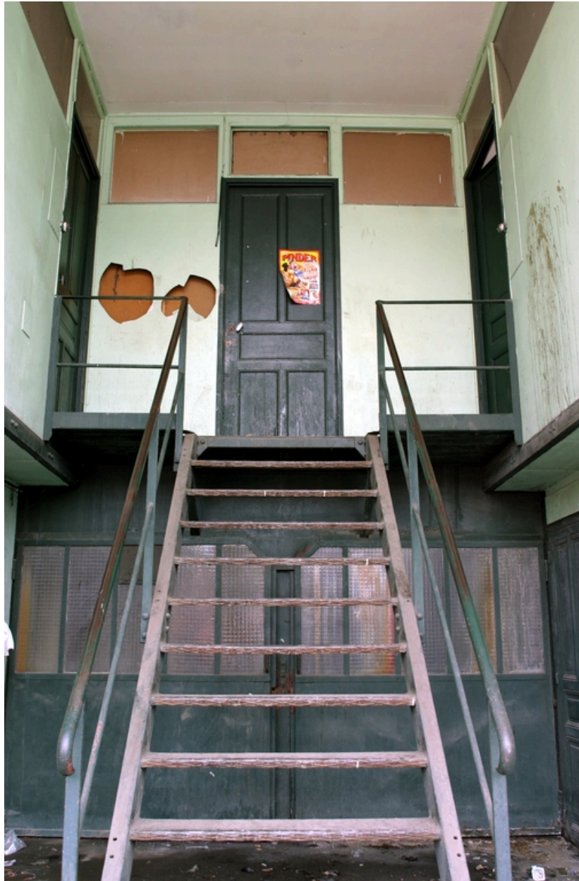
Magasin industriel : vue intérieure.
