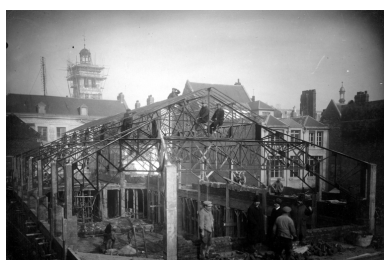
Construction d'un atelier implanté en bordure de la rue des Trois-Savoyard, à l'emplacement de l'ancienne prison, vers 1920 (BM Saint-Quentin). Phot. Pillet Frédéric IVR22_20050206686NUCAB
