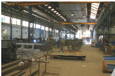
Ateliers : vue intérieure. Phot. Frédéric Pillet IVR22_20050205290NUCA
