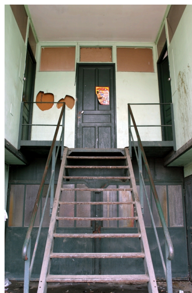
Magasin industriel : vue intérieure. Phot. Frédéric Pillet IVR22_20050205295NUCA
