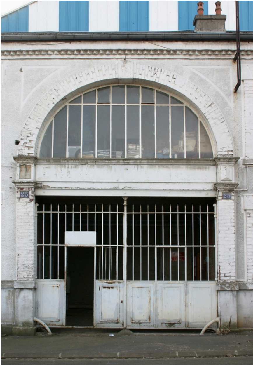
Entrée des ateliers des années 1920.
