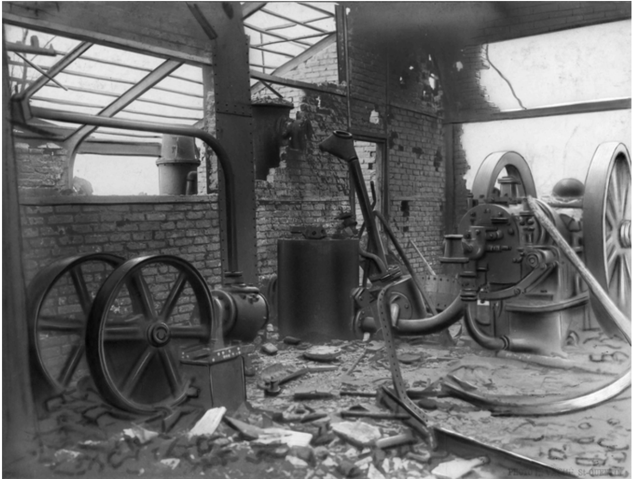
La salle des machines en ruine, vers 1919 (BM Saint-Quentin).
