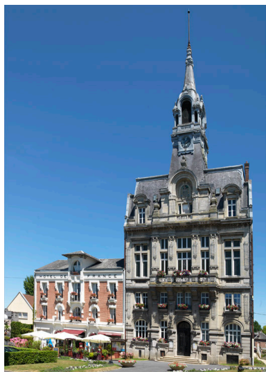
L'hôtel de ville et l'hôtel de France. Phot. Marie-Laure Monnehay-Vulliet IVR22_20158000622NUC2A
