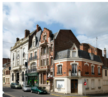
Maisons, 2, 4 et 6 place de l'Hôtel-de-Ville. Phot. Marie-Laure Monnehay-Vulliet IVR22_20158000628NUC2A
