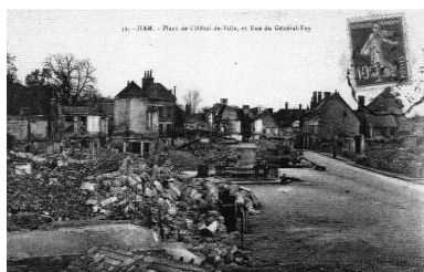
Place de l'Hôtel de Ville et Rue du Général-Foy, après les destructions de 1918 (Historial de la Grande Guerre, fonds Van Treeck). Phot. Gilles-Henri Bailly (reproduction) IVR22_20158005377NUCA
