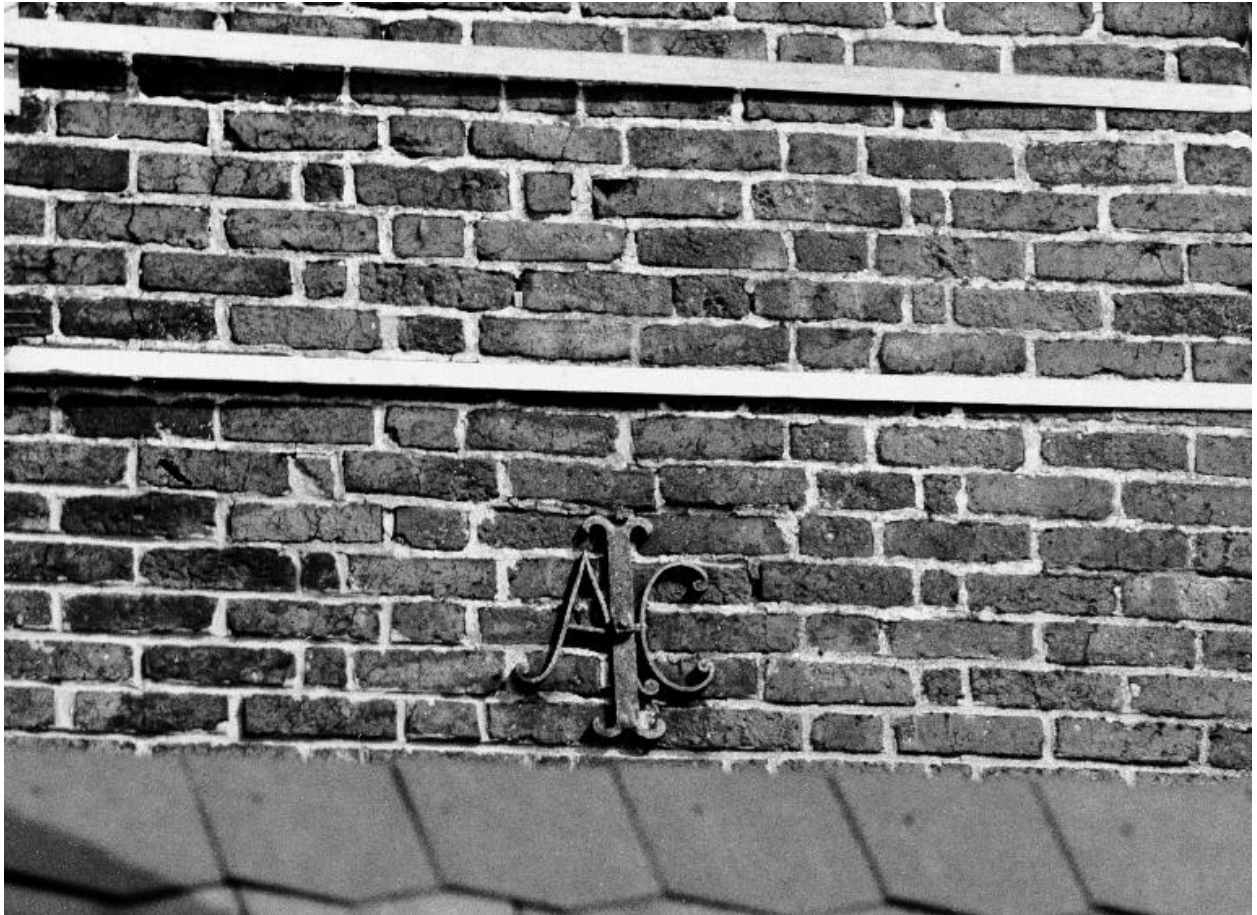
Détail de la cheminée du logement patronal : fer d'ancrage avec monogramme AC.
