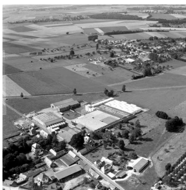
Vue aérienne, flanc sud-est. Phot. Phot'R IVR22_19888001385P
