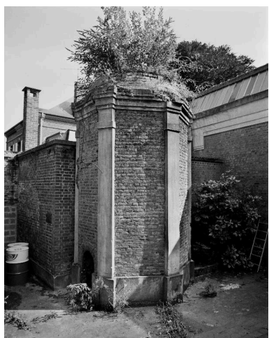
Cheminée d'usine, socle. Phot. Thierry Lefébure IVR22_19888000809V
