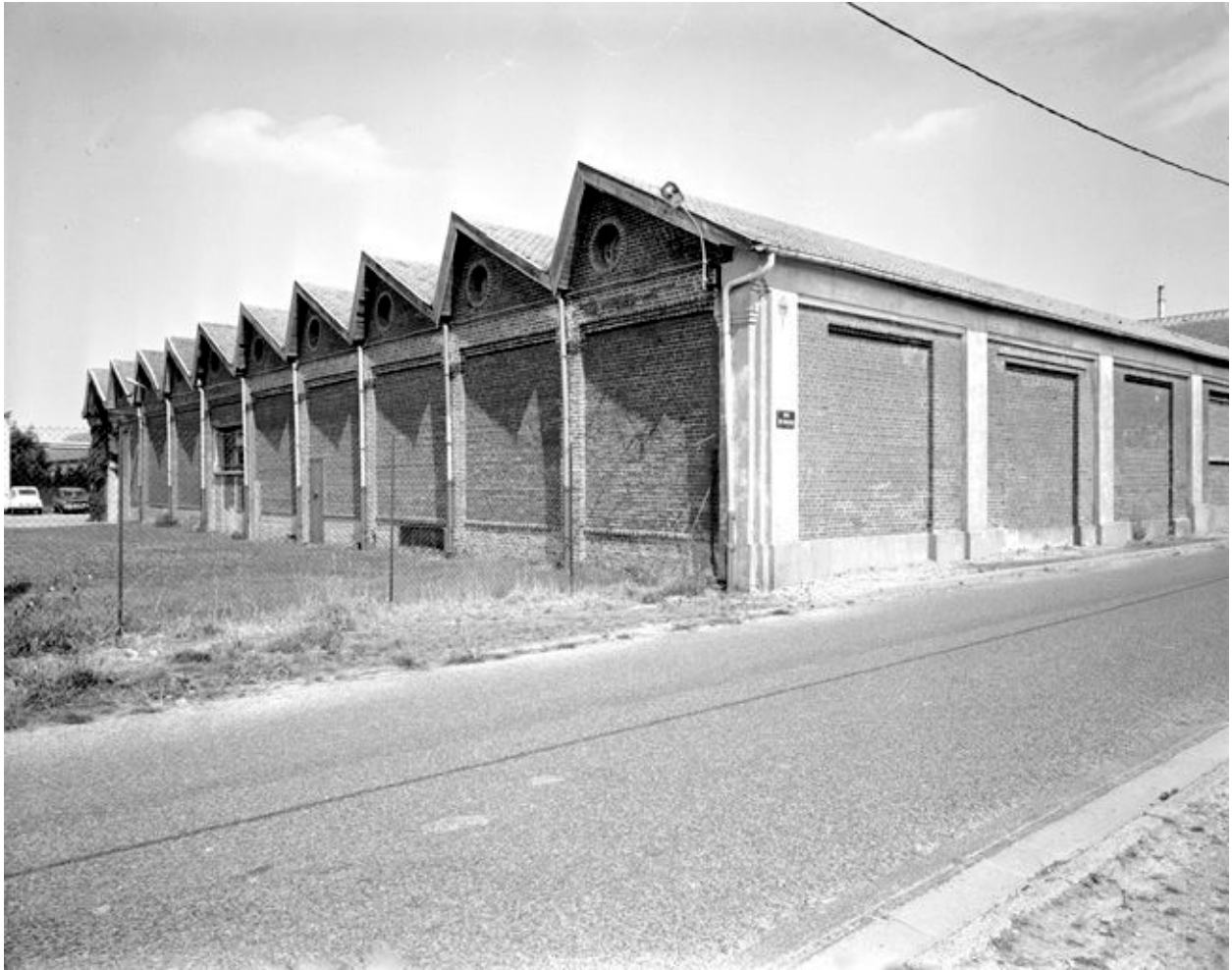
Corps du bâtiment C, flanc sud ouest.
