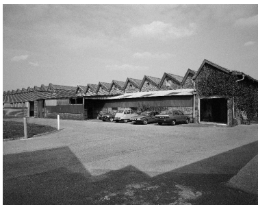
Atelier de fabrication, flanc ouest. Phot. Thierry Lefébure IVR22_19888000821V
