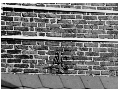
Détail de la cheminée du logement patronal : fer d'ancrage avec monogramme AC. Phot. Thierry Lefébure IVR22_19888000810X
