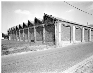
Corps du bâtiment C, flanc sud ouest. Phot. Thierry Lefébure IVR22_19888000820V
