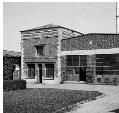
Chaufferies 1 et 2. Phot. Thierry Lefébure IVR22_19888000807V
