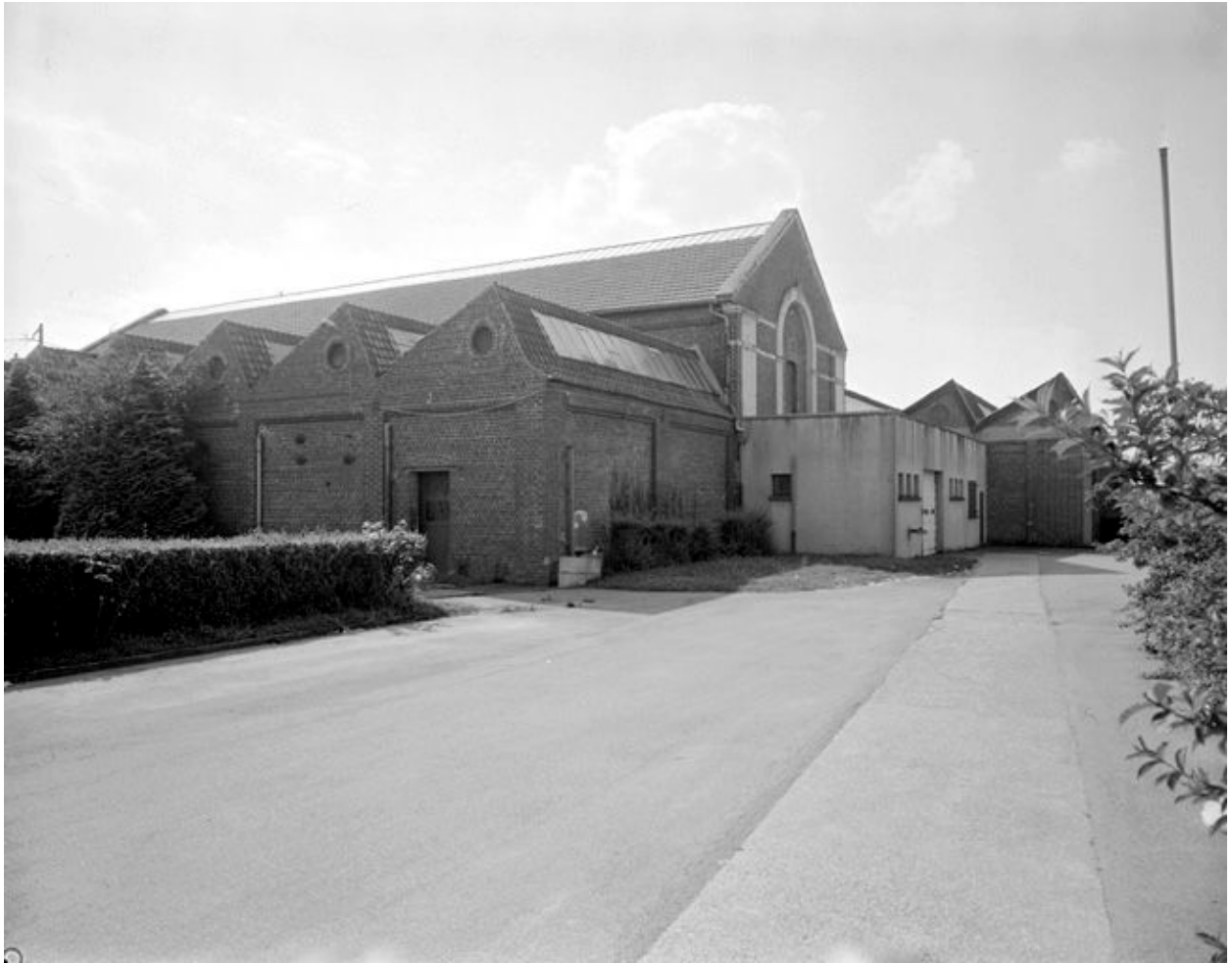
Corps du bâtiment C, flanc nord.
