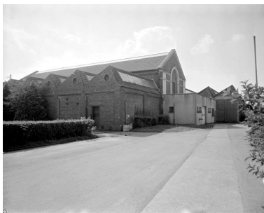
Corps du bâtiment C, flanc nord. Phot. Thierry Lefébure IVR22_19888000822V
