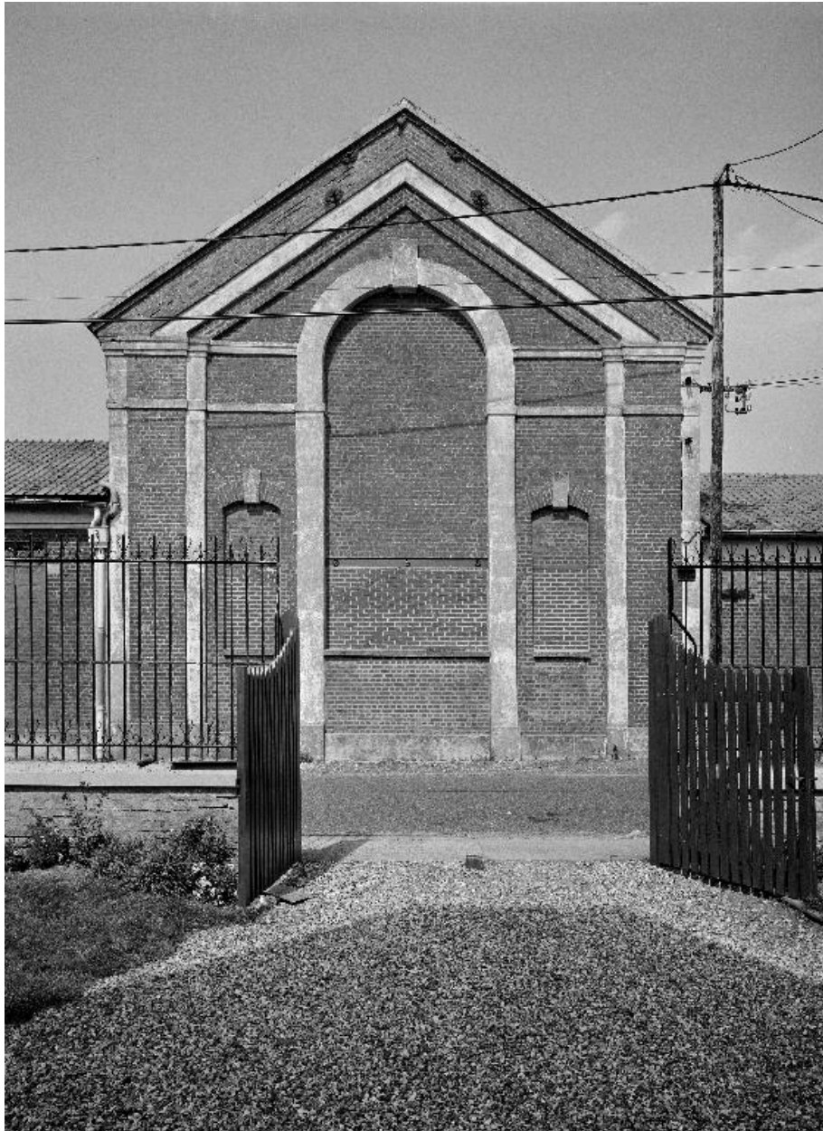
Corps de bâtiment C, flanc sud.
