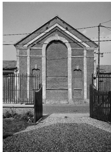
Corps de bâtiment C, flanc sud. Phot. Thierry Lefébure IVR22_19888000819V
