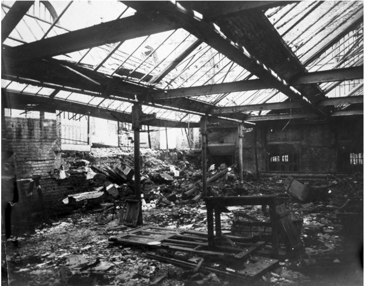
Photographie des ateliers en ruine (atelier en rez-de-chaussée implanté en fond de cour) prise avant les travaux de reconstruction (AD Aisne).
