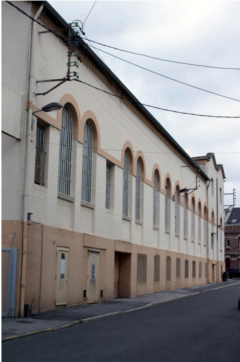
Façade des ateliers restaurés en 1919, rue Bénézet.
