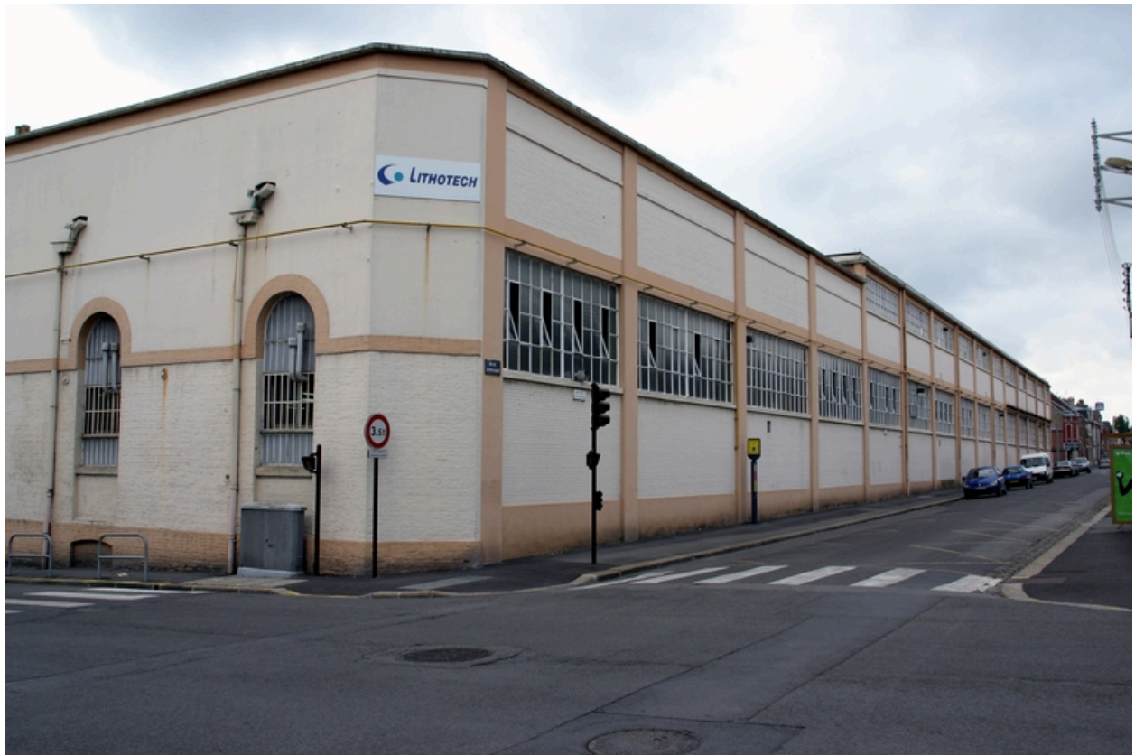
Façade des ateliers reconstruits après la Première Guerre mondiale, rue Quentin-Barré.
