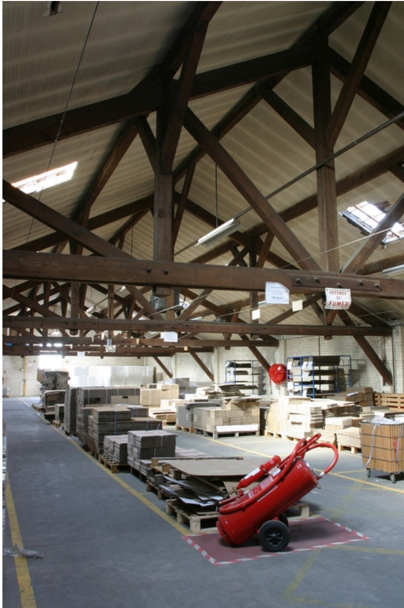
Charpente des ateliers restaurés en 1919.
