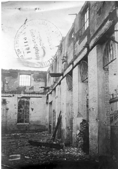
Photographie des ateliers en ruine prise avant les travaux de reconstruction (AD Aisne). Phot. Pillet Frédéric IVR22_20040200584NUCAB
