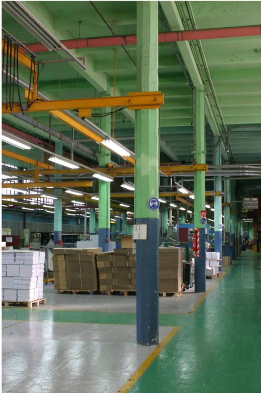
Vue intérieure des ateliers construits en 1919.
