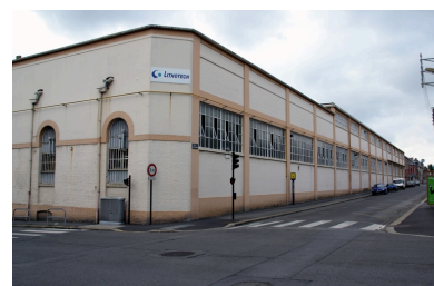
Façade des ateliers reconstruits après la Première Guerre mondiale, rue Quentin-Barré. Phot. Frédéric Pillet IVR22_20040200729NUCA
