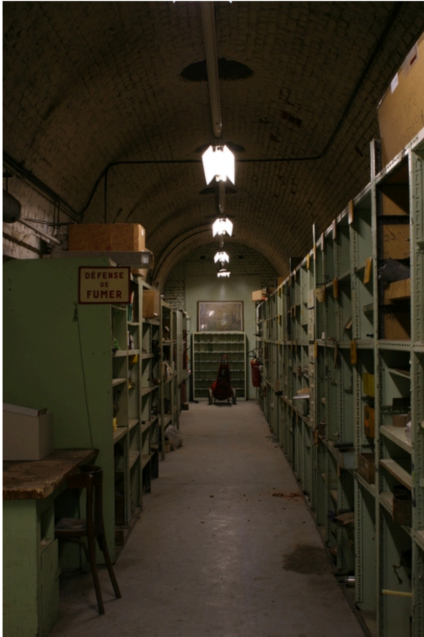
Sous-sols des ateliers : ancien lieu de stockage du charbon (la voûte est percée d'orifices circulaires).
