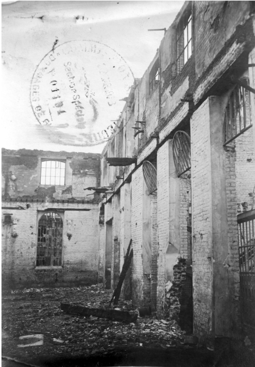
Photographie des ateliers en ruine prise avant les travaux de reconstruction (AD Aisne).
