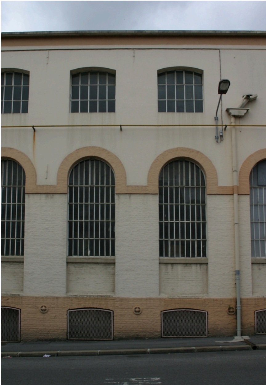
Détail de la façade des ateliers, rue de Mulhouse.
