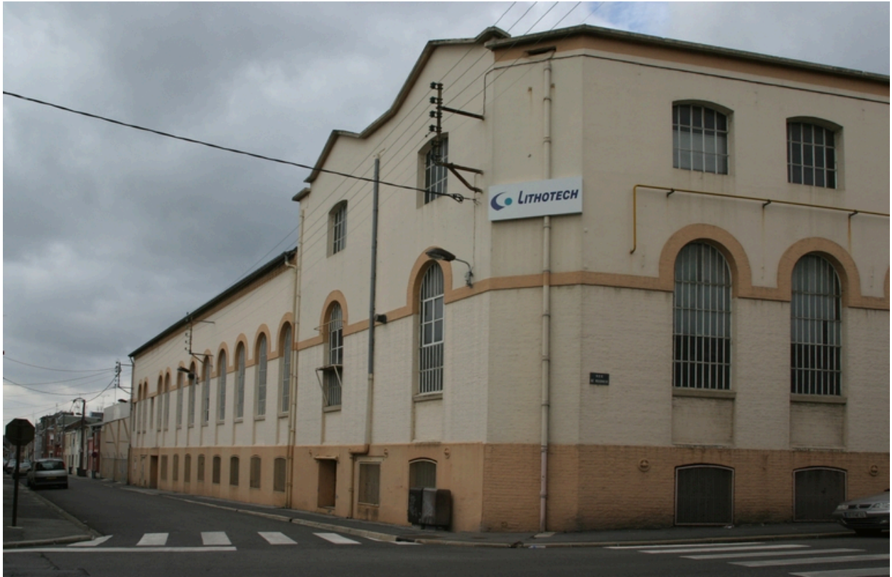
La façade des ateliers restaurés en 1919, à l'angle des rues Bénézet et de Mulhouse.
