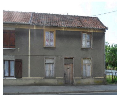
Façade d'un logement. Phot. Isabelle Barbedor IVR22_20108001494NUCA
