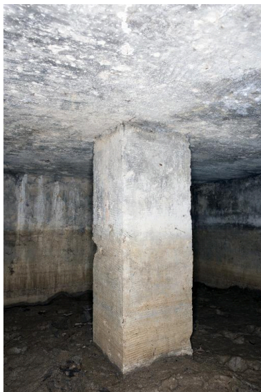
Pilier de soutènement de la salle principale Phot. Pierre Thibaut IVR31_20155900641NUCA
