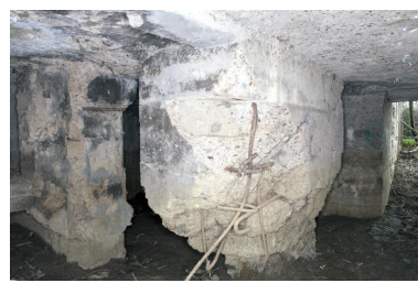
Depuis le porche pare- souffle, accès à l'édifice
