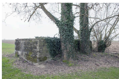
Vue de trois-quart arrière, vers le sud
