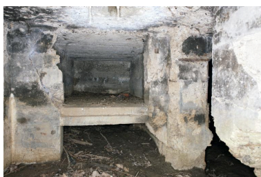
Vue interieure. Resserre à mitrailleuse
