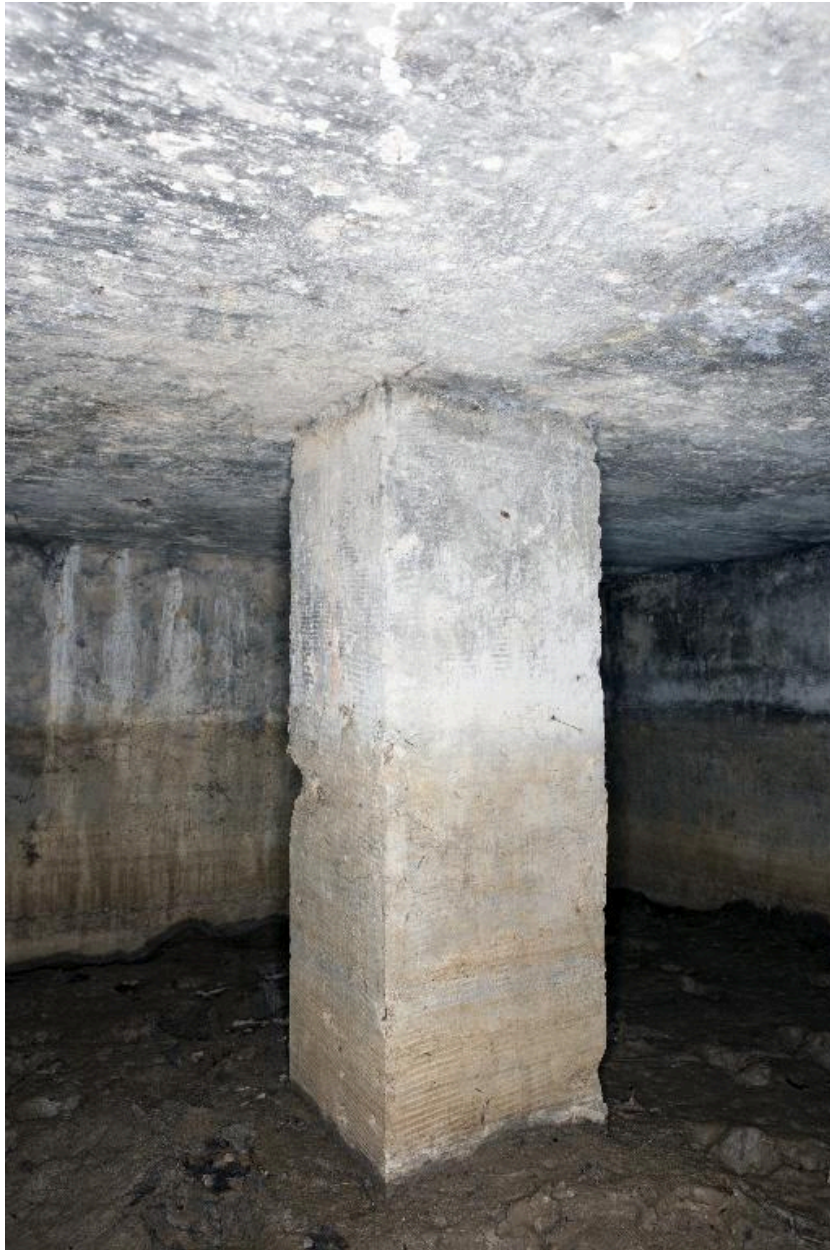
Pilier de soutènement de la salle principale
