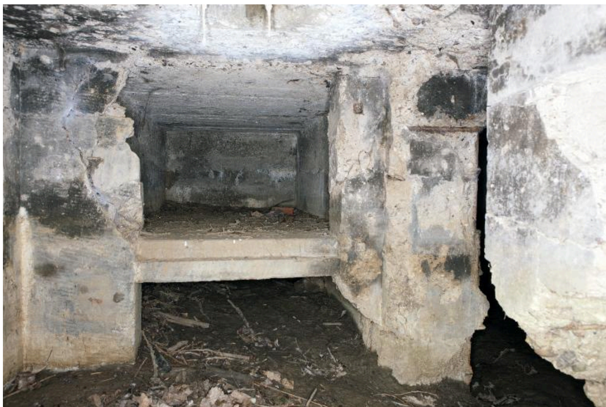
Vue interieure. Resserre à mitrailleuse
