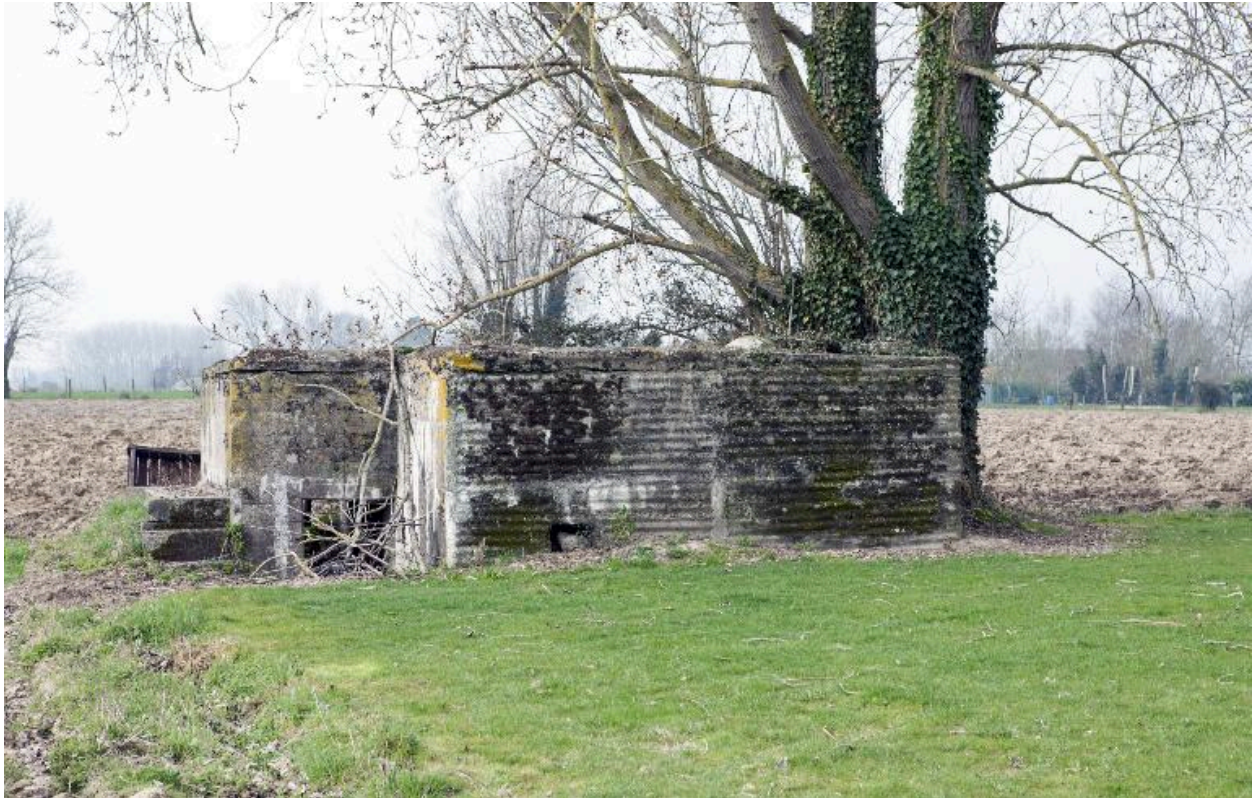
Vue de trois-quarts, vers l'ouest. De gauche à droite : l'escalier menant à la banquette de tir, l'entrée latérale est, sous le porche pare-souffle
