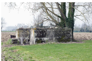
Vue de trois-quarts, vers l'ouest. De gauche à droite : l'escalier menant à la banquette de tir, l'entrée latérale est, sous le porche pare-souffle Phot. Pierre Thibaut IVR31_20155900628NUCA
