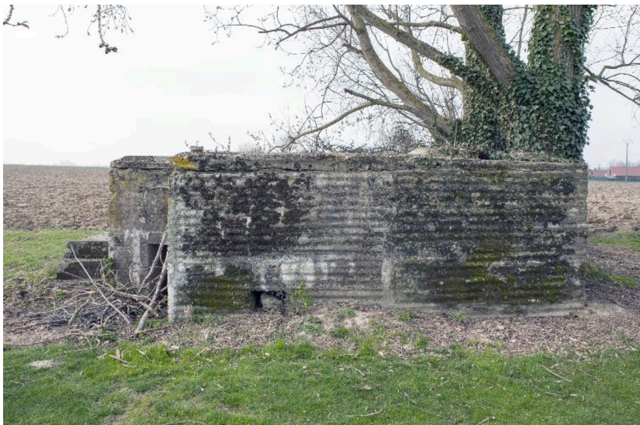
Vue latérale de l'édifice, vers le sud-ouest.
