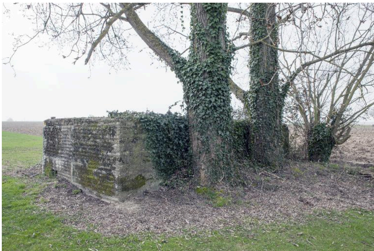
Vue de trois-quart arrière, vers le sud
