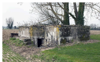
Vue de trois-quarts, vers le nord- ouest. Sur la gauche, la banquette de tir et le porche pare-souffle. Phot. Jean-Marc Ramette IVR31_20155900629NUCA
