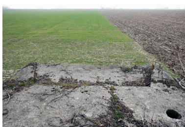
Le couvrement avec la cuve à mitrailleuse, vers le sud-est Phot. Pierre Thibaut IVR31_20155900634NUCA
