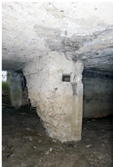
Depuis le porche pare-souffle, mur sud percé d'un créneau de fusillade Phot. Jean-Marc Ramette IVR31_20155900640NUCA
