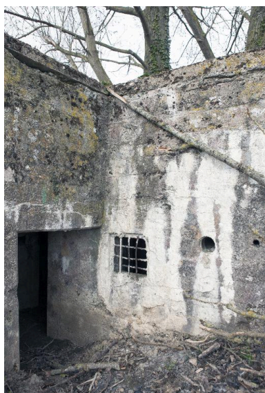
L'entrée latérale est du porche pare-souffle. A sa droite, une baie munie de barreaux et une aération Phot. Pierre Thibaut IVR31_20155900637NUCA
