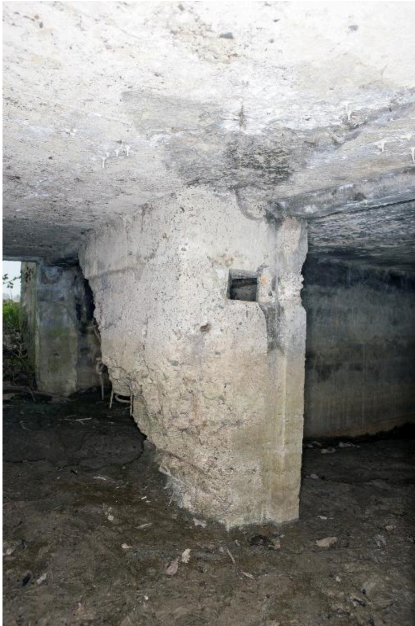
Depuis le porche pare-souffle, mur sud percé d'un créneau de fusillade
