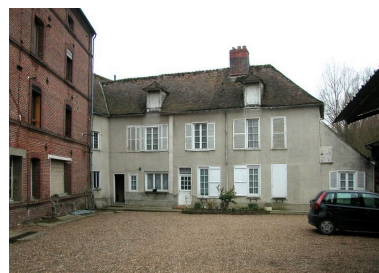
Le logement, façade sur cour.
