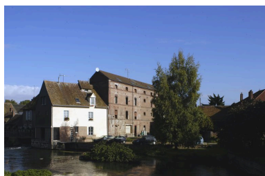
Vue d'ensemble du moulin hydraulique, de la minoterie et des vannes de décharge.
