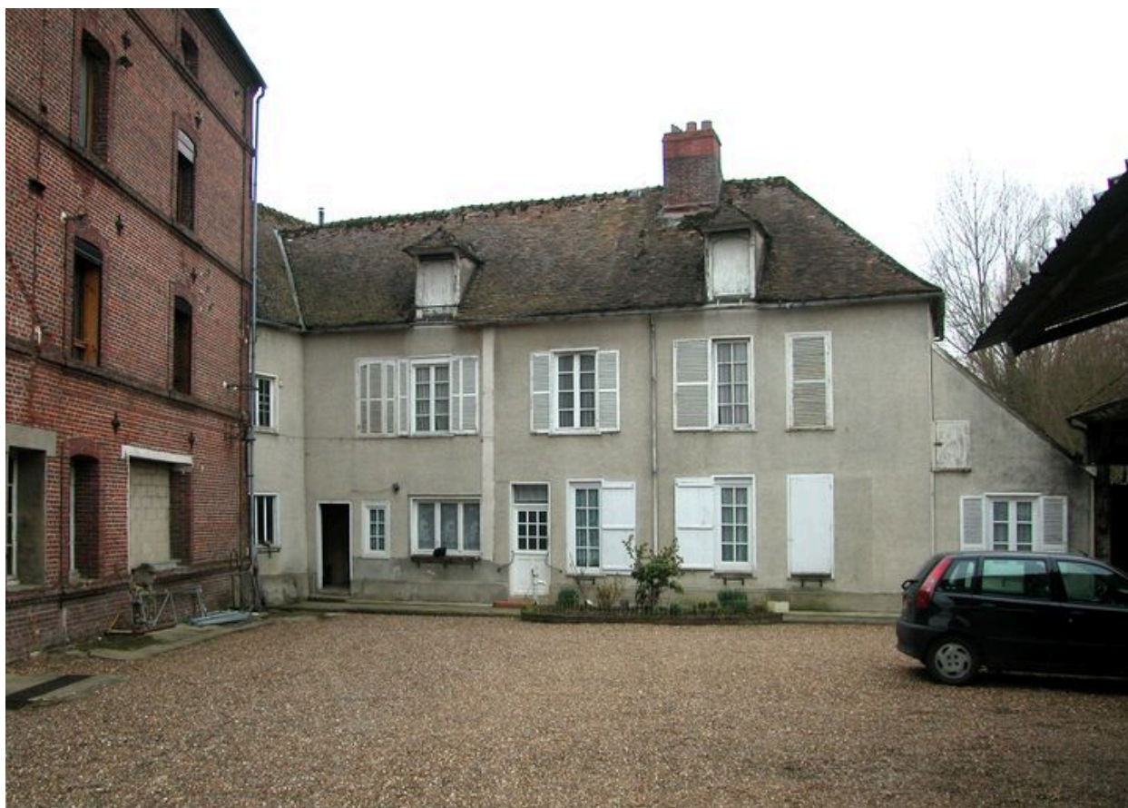
Le logement, façade sur cour.
