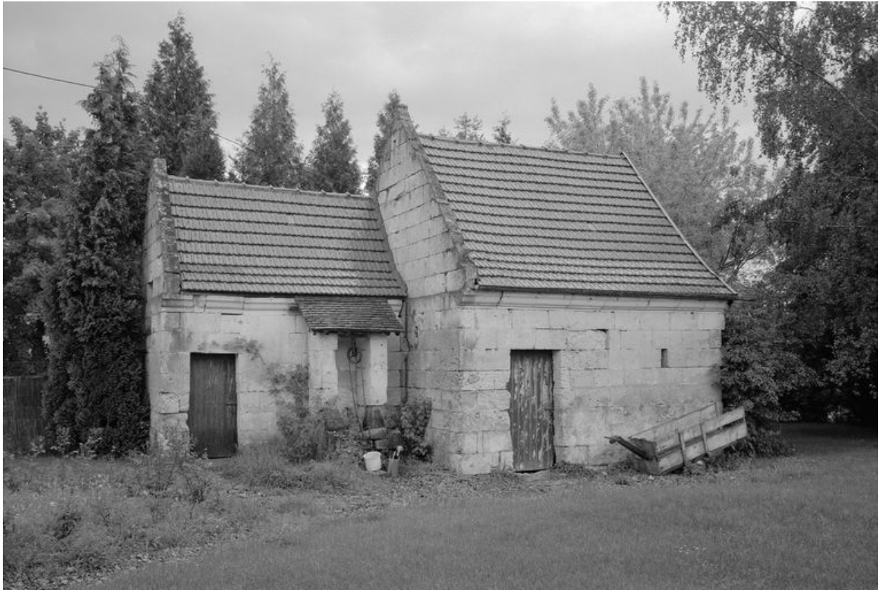
Remise et puits.
