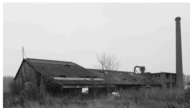
Vue générale. Phot. Benoît Dufournier IVR22_19936002449Z
