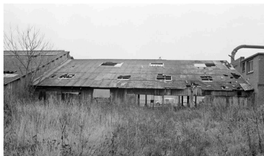
Atelier de fabrication principal. Phot. Benoît Dufournier IVR22_19936002457Z
