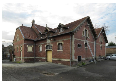
Vue d'ensemble du magasin de la prévoyance, vue de trois-quarts. Phot. Thierry Lefébure IVR22_20138000500NUC2A
