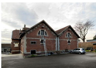
Façade postérieure du magasin de la Prévoyance. Phot. Thierry Lefébure IVR22_20138000501NUC2A
