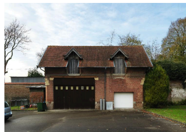
Façade sur cour du bûcher et de la la remise de la Prévoyance. Phot. Thierry Lefébure IVR22_20138000503NUC2A
