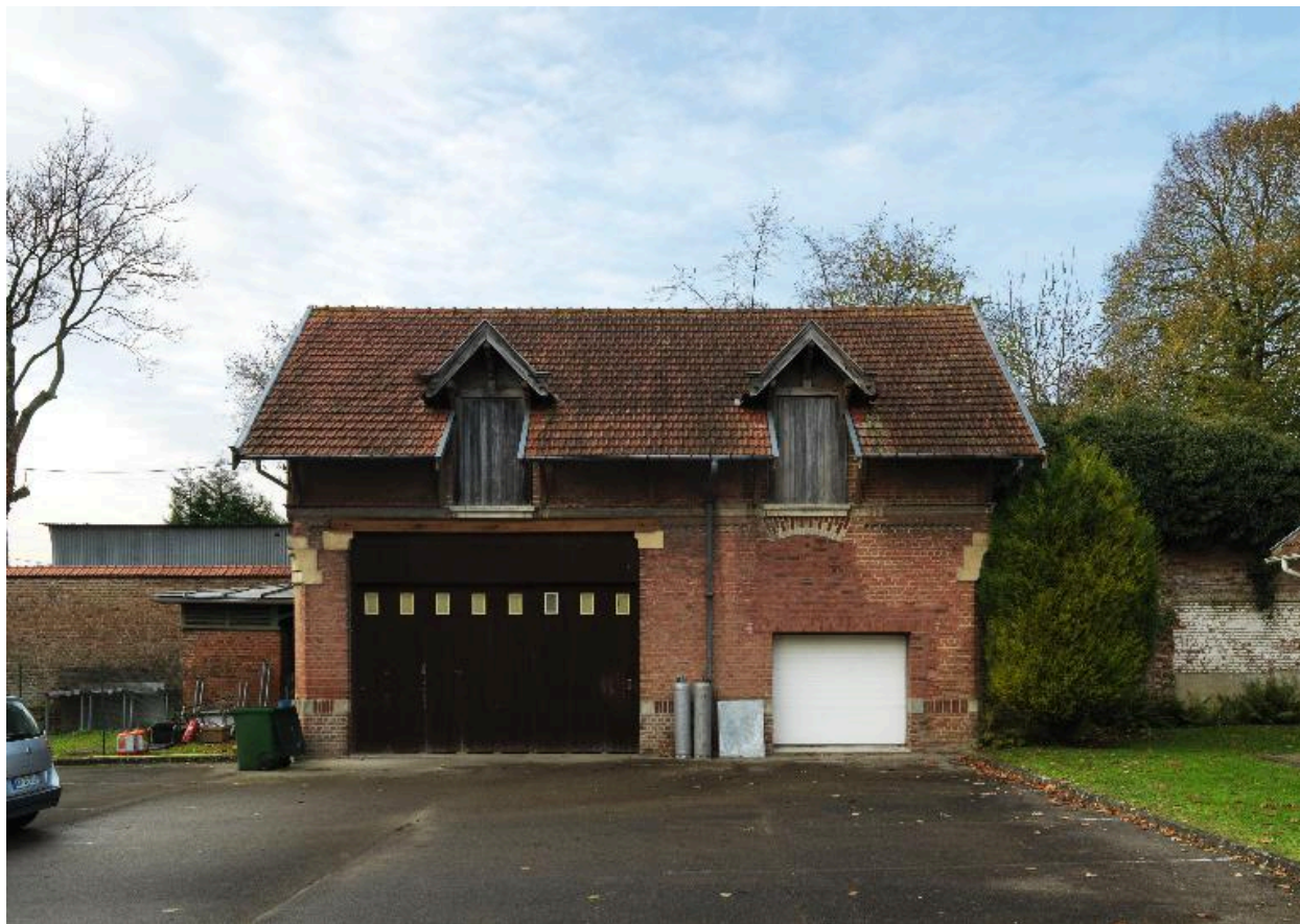
Façade sur cour du bûcher et de la la remise de la Prévoyance.
