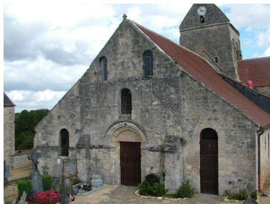
Vue générale de l'élévation occidentale. Phot. Frédéric Fournis IVR22_20040202965NUC1A
