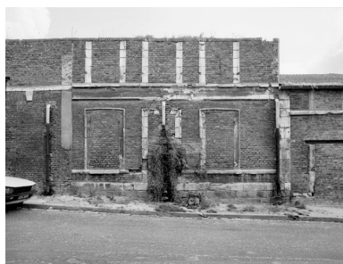
Atelier de fabrication, en 1989. La façade sur la rue Turgot conserve la trace des anciens logements détruits pour la construction de la teinturerie. Phot. Thierry Lefébure IVR22_19898000202X
