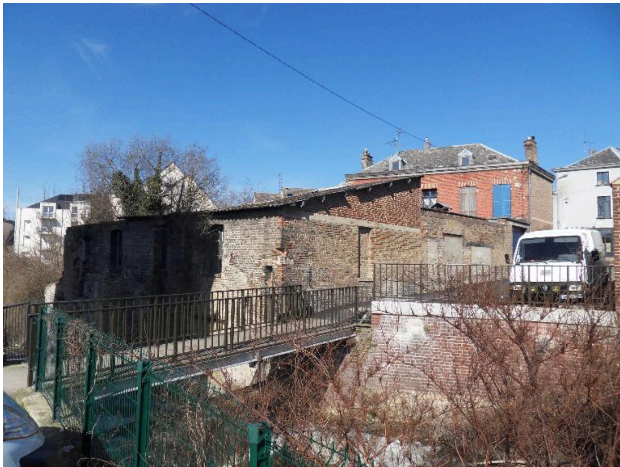
La passerelle, au bas de la rue Bizet, et les vestiges de l'ancien moulin.
