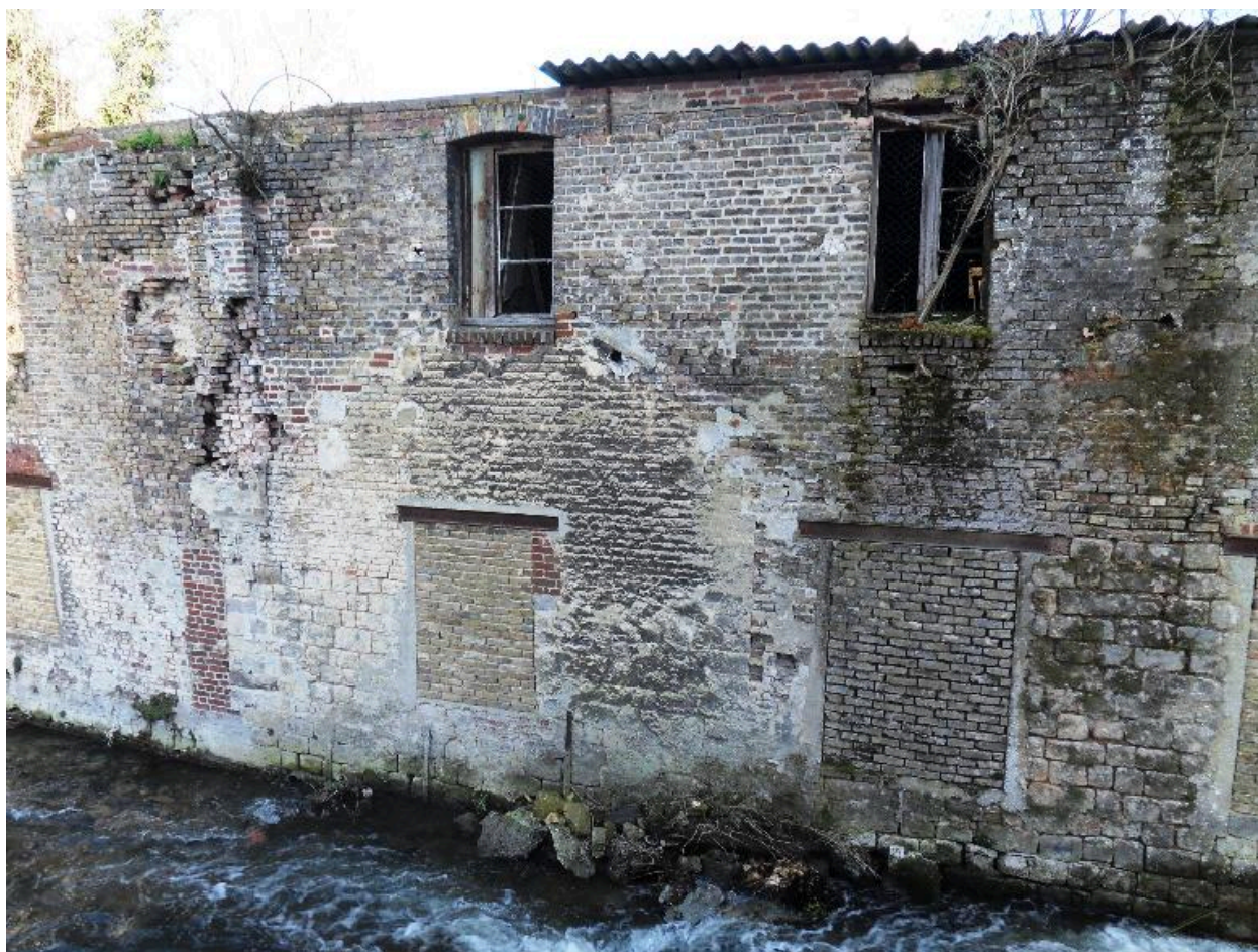
Vestiges de l'ancien moulin, rive nord du canal.
