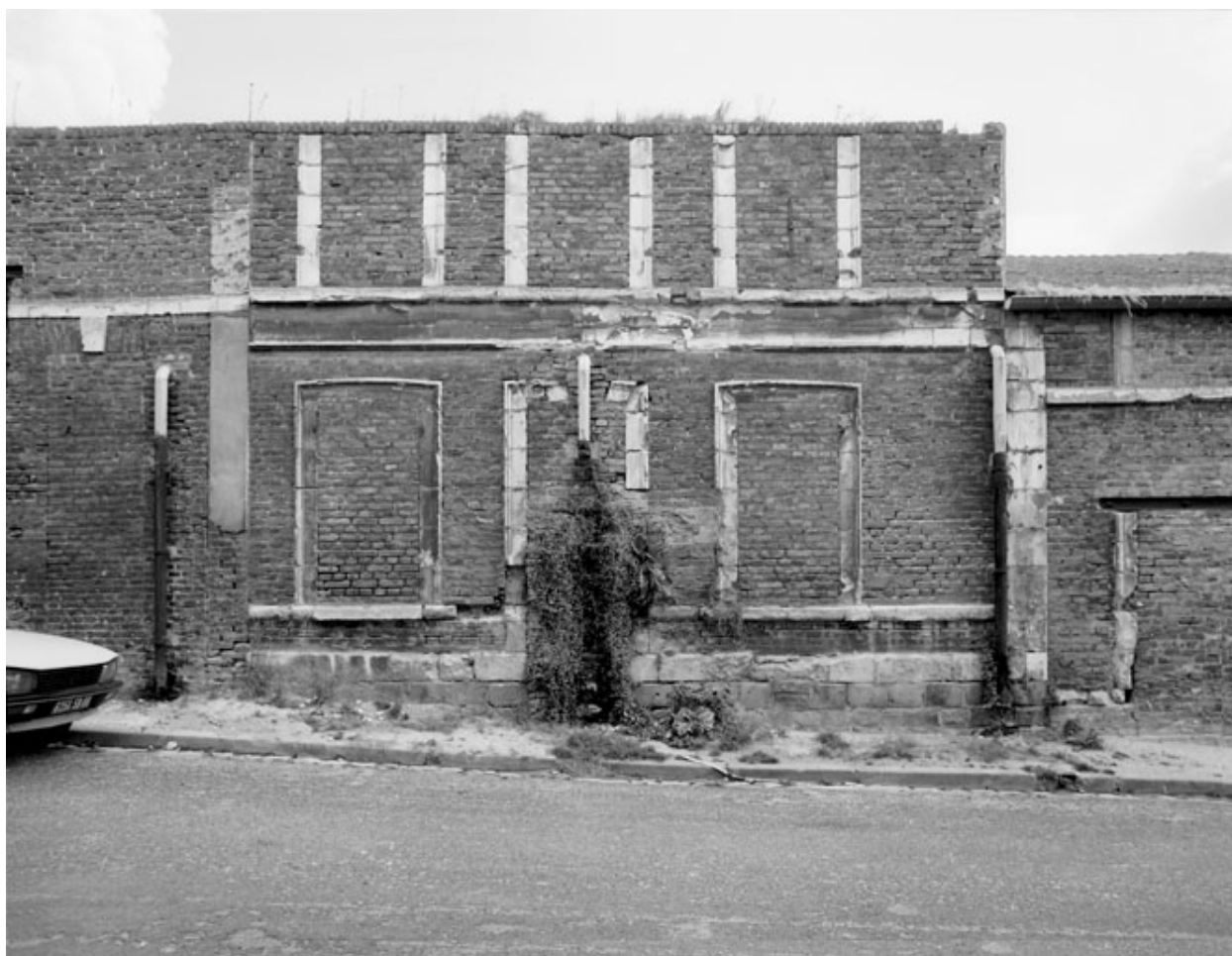
Atelier de fabrication, en 1989. La façade sur la rue Turgot conserve la trace des anciens logements détruits pour la construction de la teinturerie.
