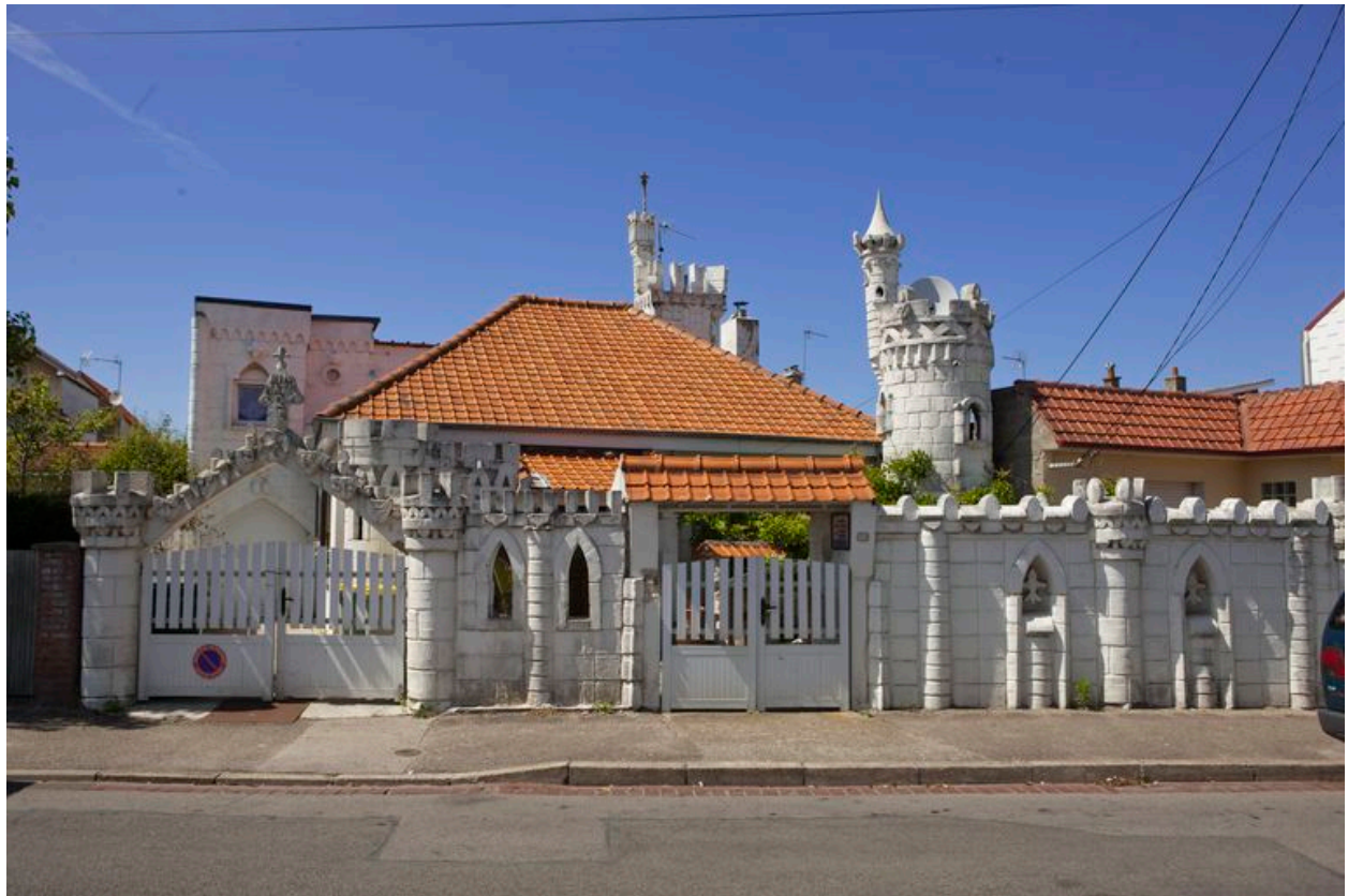
La maison construite par Joseph Meyer à Berck
