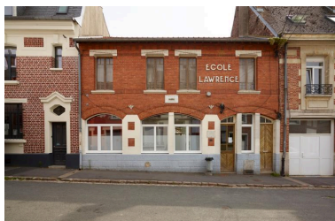
Vue générale. Phot. Hubert Bouvet IVR32_20196200926NUC4A
