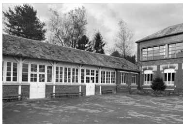
Vue du préau couvert. Phot. Pierre-Yves Brest IVR22_19990207103Z
