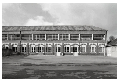
Vue de face de la façade sur cour du bâtiment des classes. Phot. Pierre-Yves Brest IVR22_19990207105Z
