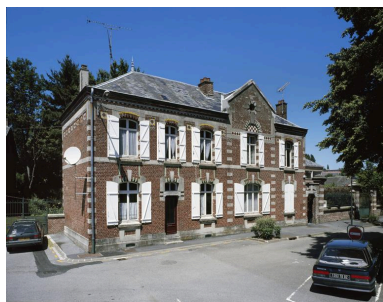
Vue du pavillon Ouest, abritant le logement de la directrice de l'école maternelle et de son adjointe. Phot. Franck Bürjes IVR22_20000201877VA
