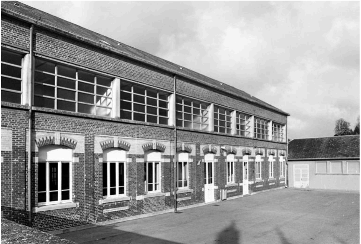
Vue de la façade sur cour du bâtiment des classes (surélevé d'un niveau en 1951).
