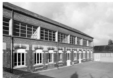
Vue de la façade sur cour du bâtiment des classes (surélevé d'un niveau en 1951). Phot. Pierre-Yves Brest IVR22_19990207104Z
