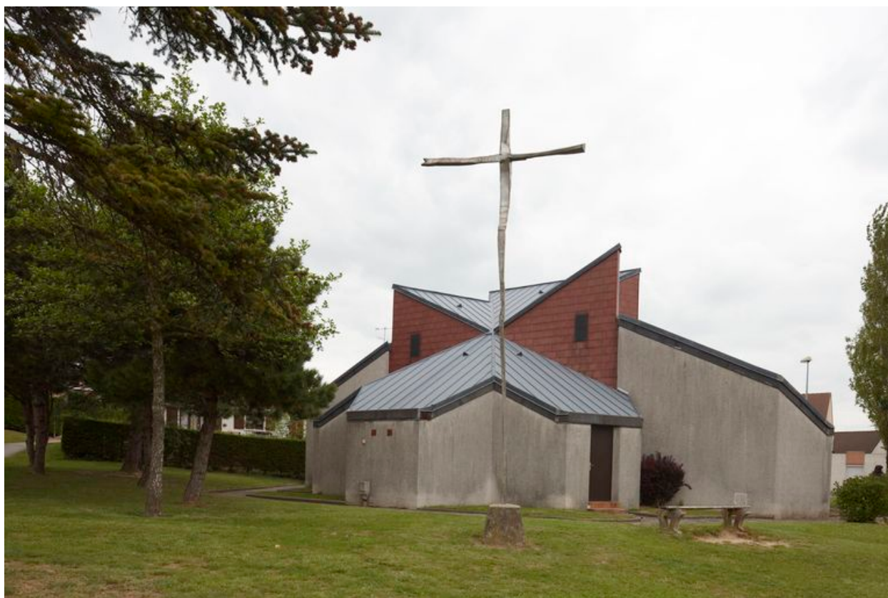
Vue générale de l'édifice depuis l'avenue du Vieux Moulin.
