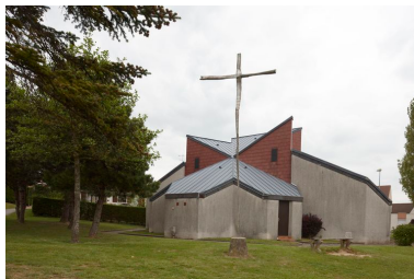
Vue générale de l'édifice depuis l'avenue du Vieux Moulin. Phot. Hubert Bouvet IVR31_20106200753NUCA
