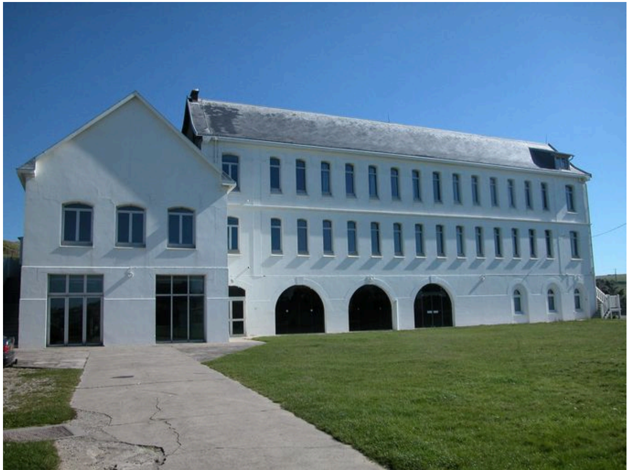
Vue d'ensemble, état en 2005.
