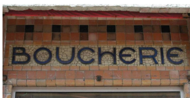
Détail de la mosaïque portant dénomination de l'édifice. Phot. Elisabeth Justome IVR22_20038005371NUCA
