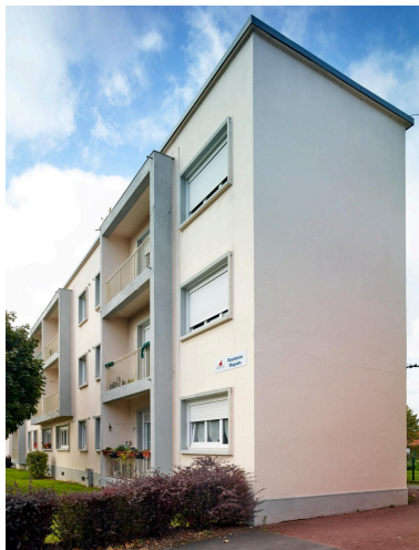
Vue du bloc A côté rue. Phot. Pierre Thibaut IVR32_20205900013NUCA
