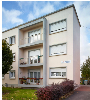
Vue du bloc A côté rue. Phot. Pierre Thibaut IVR32_20205900014NUCA
