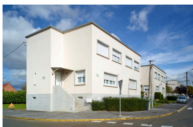
Vue des pavillons situés aux extrémités de l'opération (bloc C), prise depuis la rue. Phot. Pierre Thibaut IVR32_20205900003NUCA
