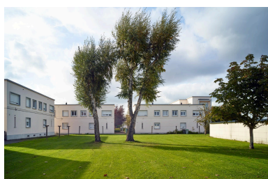
Vue arrière des pavillons, prise depuis les jardins. Phot. Pierre Thibaut IVR32_20205900017NUCA
