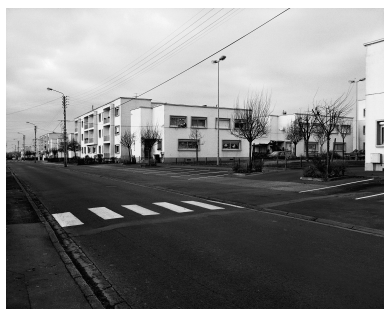
Vue générale de l'articulation rue-place. Phot. Thierry Petitberghien IVR31_20025900378X
