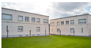
Vue arrière des pavillons, prise depuis les jardins. Phot. Pierre Thibaut IVR32_20205900012NUCA
