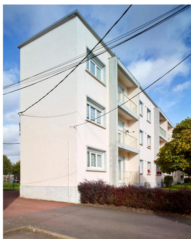
Vue du bloc A côté rue. Phot. Pierre Thibaut IVR32_20205900015NUCA
