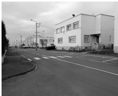
Vue générale depuis la rue (sud). Phot. Thierry Petitberghien IVR31_20025900376X
