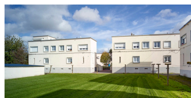
Vue arrière des pavillons, prise depuis les jardins. Phot. Pierre Thibaut IVR32_20205900024NUCA
