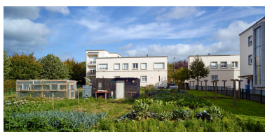
Vue générale de la frange nord de l'opération, initialement occupée par des clapiers et des potagers, aujourd'hui espace vert sans usage particulier. Phot. Pierre Thibaut IVR32_20205900007NUCA
