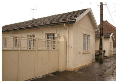
Façade antérieure. Phot. Frédéric Pillet IVR22_20060205256NUCA
