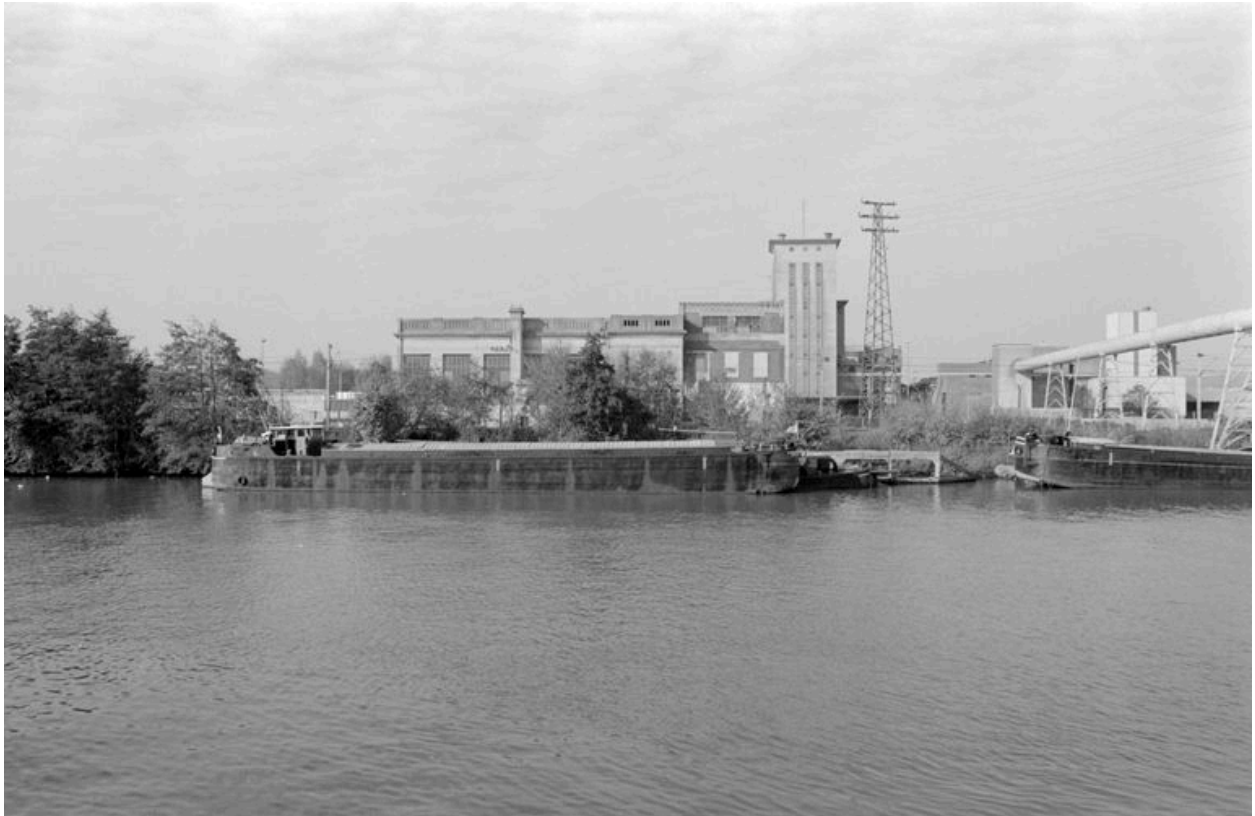
CLAIROUX. Compagnie électrique du Nord. Vue générale, flanc est.
