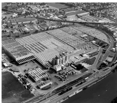
COMPIEGNE. Vue aérienne d'une usine, avenue de Vermandois. Phot. Phot'R IVR22_19916000199P
