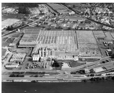
COMPIEGNE. Vue aérienne d'une usine, avenue de Vermandois. Phot. Phot'R IVR22_19916000198P
