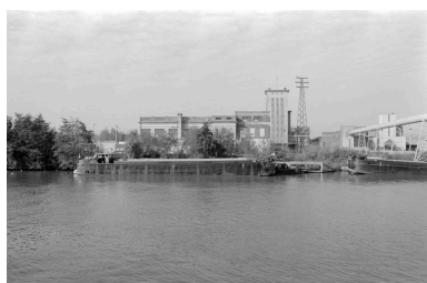
CLAIROIX. Compagnie électrique du Nord. Vue générale, flanc est. Phot. Benoît Dufournier IVR22_19936002346Z
