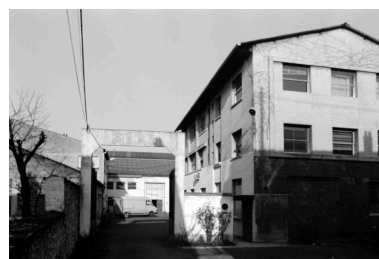
MARGNY-LES-COMPIEGNE. Usine d'emballage et conditionnement, dite usine Etude Exploitation Techniques. Ateliers de fabrication.
