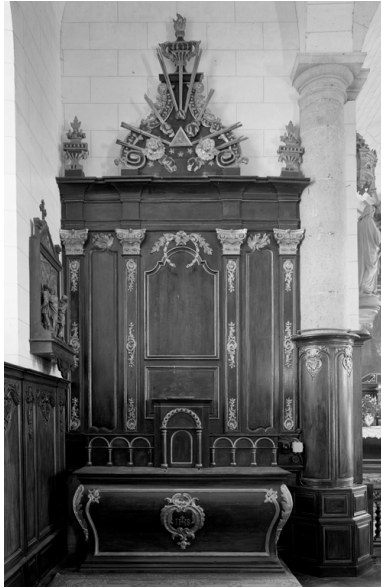
Vue du retable en bois de la chapelle nord, installé dans le 4 e quart du XVIII e siècle. Phot. Thierry Lefébure IVR22_19910200705V
