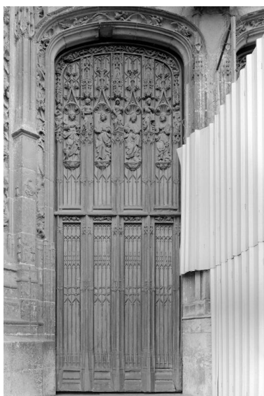
Vue du vantail gauche du portail nord. Phot. Laurent Jumel IVR22_19966003774X
