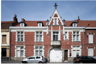
Élévation antérieure du logement rue Jules-Ferry. Phot. Delphine Volto-Jourdan IVR32_20225900157NUCA
