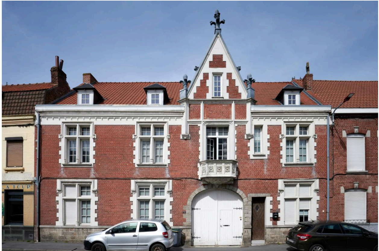
Élévation antérieure du logement rue Jules-Ferry.
