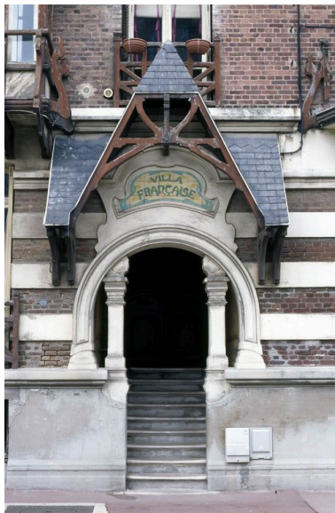
Détail du porche d'entrée. Phot. Marie-Laure Monnehay-Vulliet IVR22_20048000126XA
