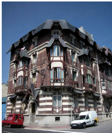
Vue d'ensemble depuis l'avenue du Maréchal-Foch. Phot. Elisabeth Justome IVR22_20038005266NUCA
