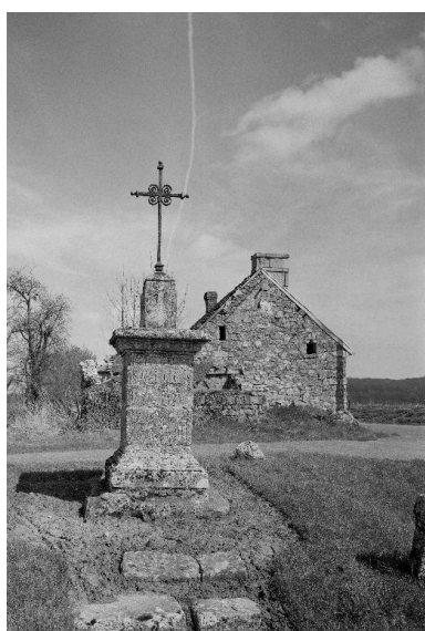
Vue générale de la croix et de son environnement. Phot. Fabrice Charrondière IVR22_19860200309X
