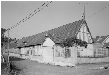
Elévation antérieure. Phot. Jean-Michel Perrin IVR22_19856000881X
