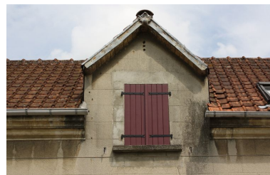
Détail de la lucarne passante à bâtière. Phot. Bertrand Fournier IVR22_20098005131NUCA
