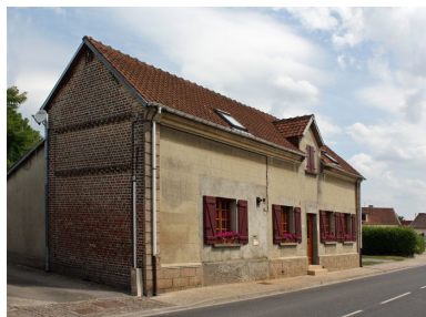
Vue d'ensemble sur rue. Phot. Bertrand Fournier IVR22_20098005129NUCA
