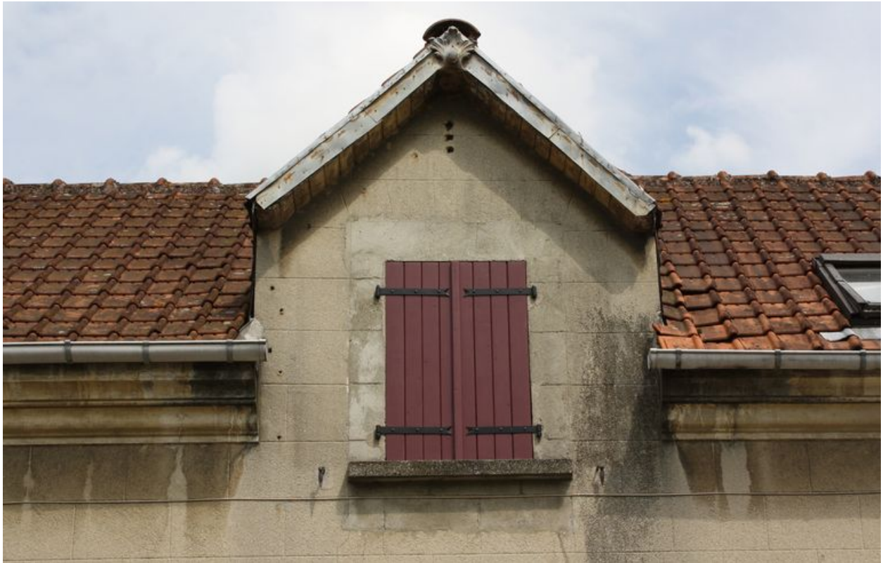
Détail de la lucarne passante à bâtière.
