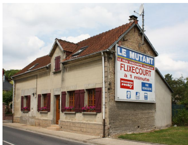
Vue d'ensemble sur rue. Phot. Bertrand Fournier IVR22_20098005130NUCA
