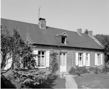
Vue antérieure. Phot. Irwin Leullier IVR22_19978000685X
