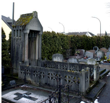
Vue générale de trois-quarts. Phot. Thierry Lefébure IVR22_20058000368NUCA
