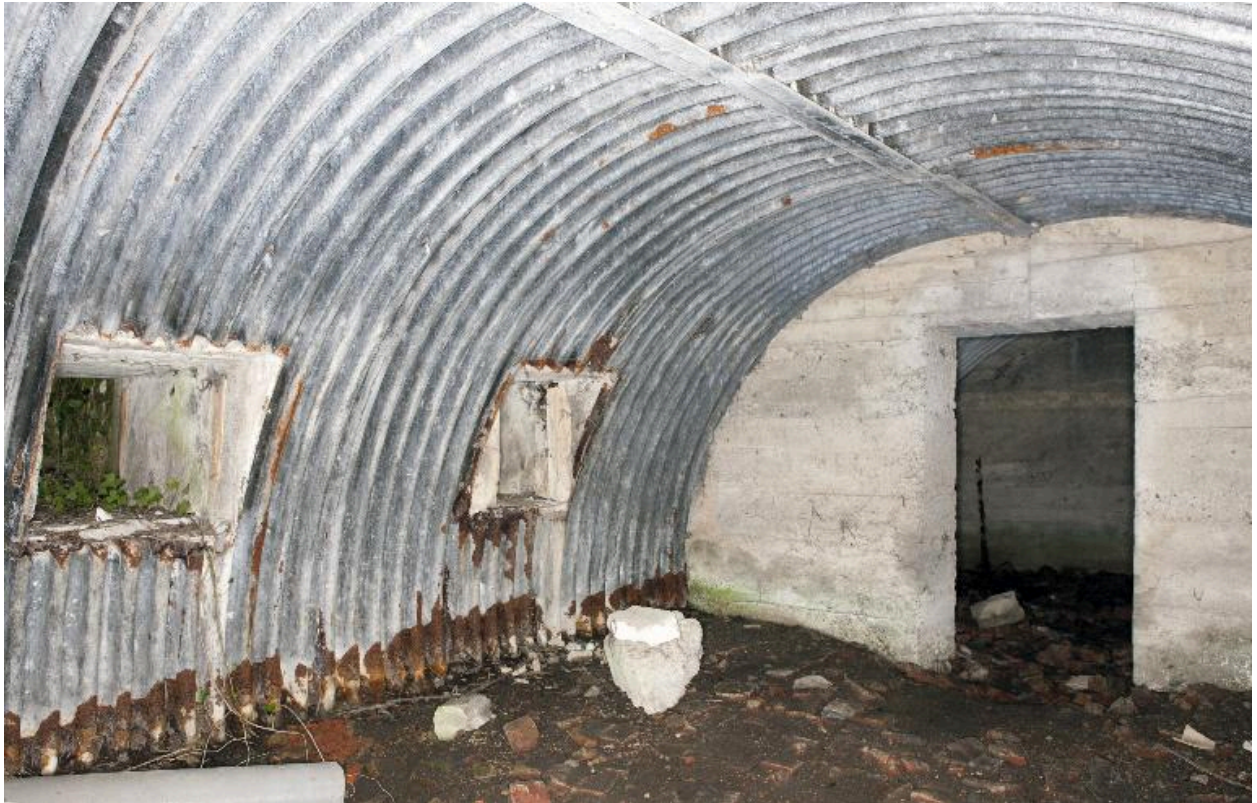
Vue intérieure de la salle Sud-Est depuis l'entrée
