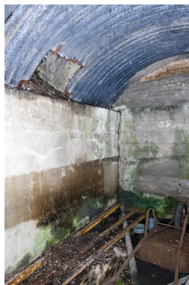
Vue intérieure de la salle Nord. En haut, à gauche, le débouché d'une ouverture traversant obliquement le couverture Phot. Pierre Thibaut IVR31_20155900612NUCA
