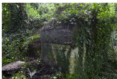
Pignon ouest Phot. Jean-Marc Ramette IVR31_20145904284NUCA
