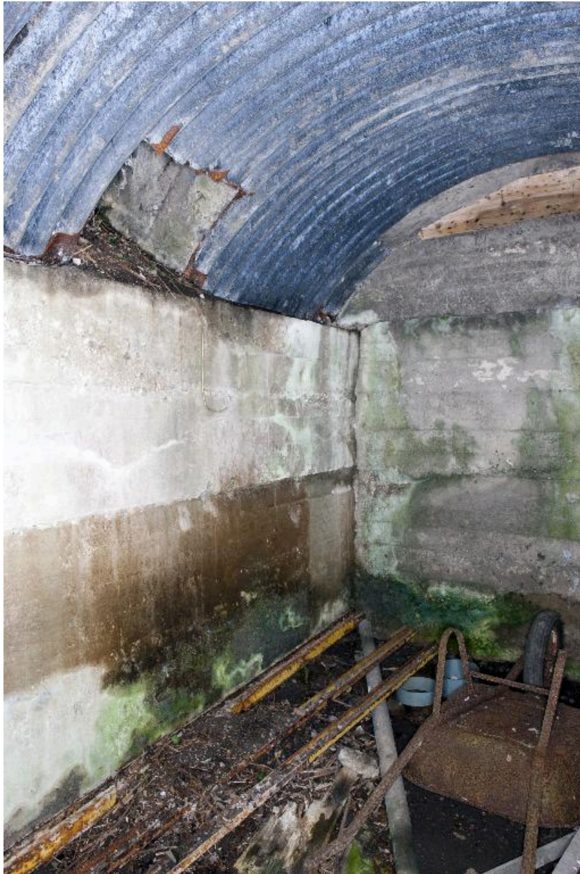
Vue intérieure de la salle Nord. En haut, à gauche, le débouché d'une ouverture traversant obliquement le couverture
