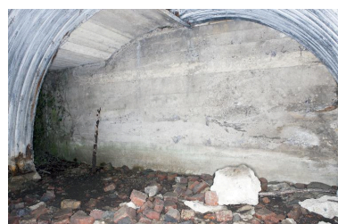
Vue intérieure de la salle Sud-ouest, vers l'entrée Phot. Pierre Thibaut IVR31_20155900616NUCA
