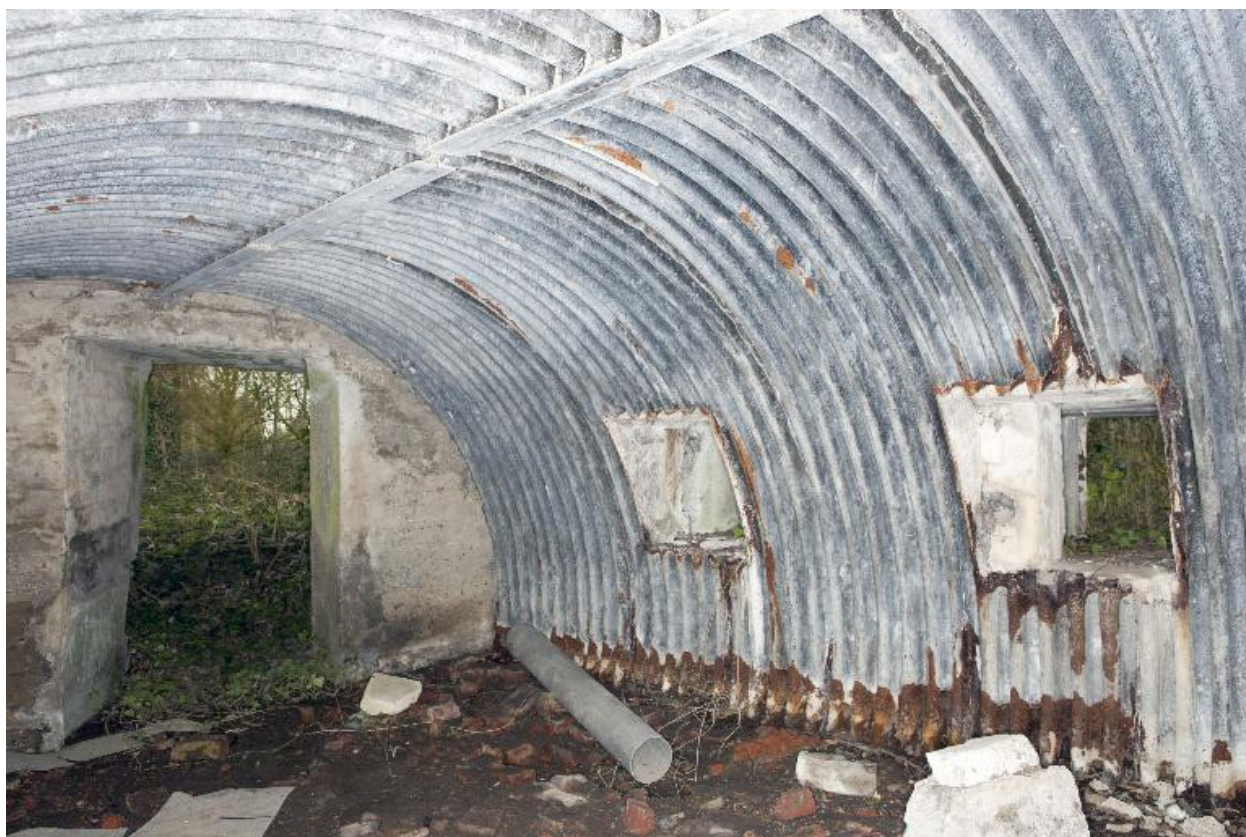
Vue intérieure de la salle Sud-Est, vers l'entrée
