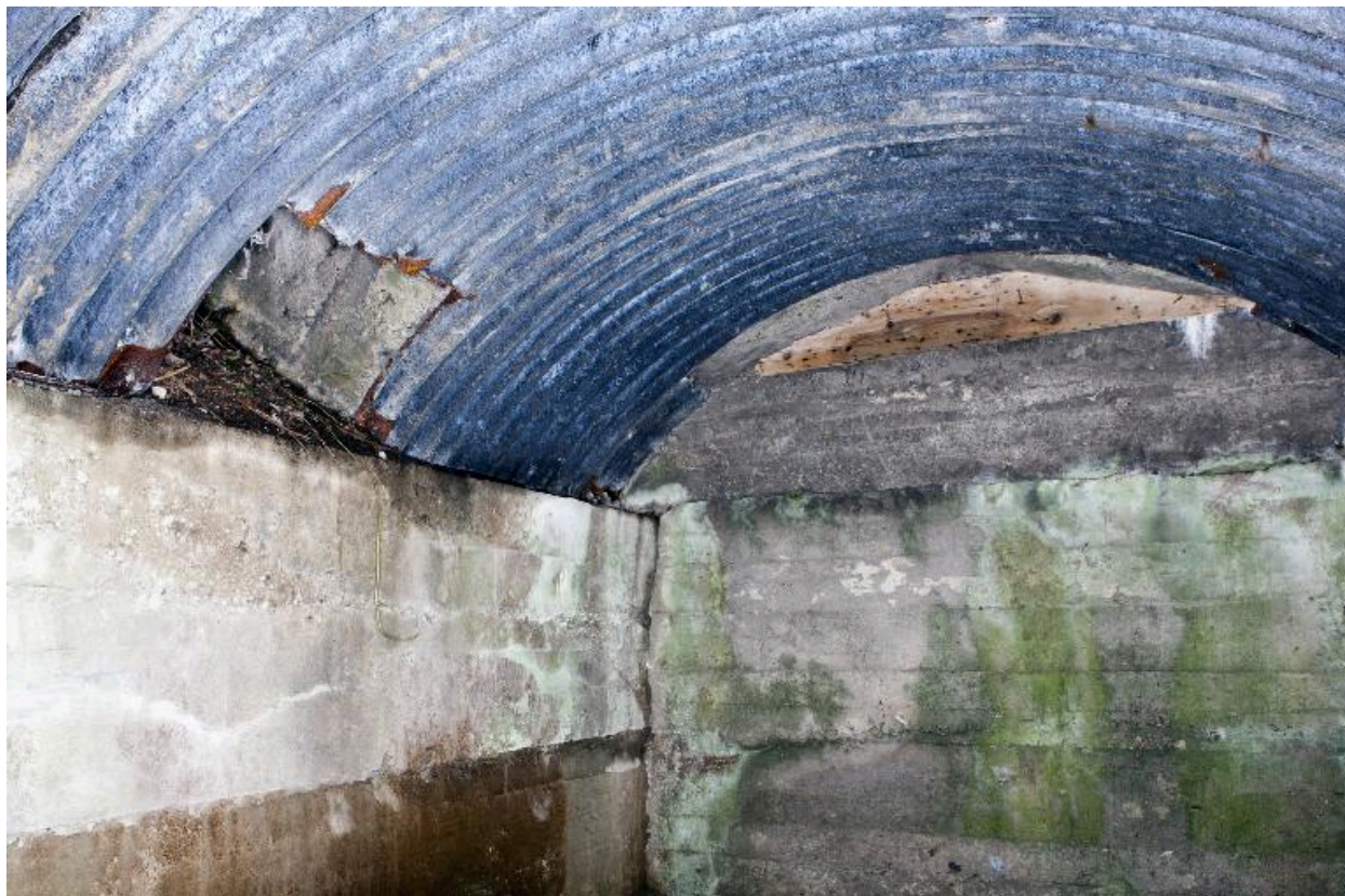
Vue intérieure de la salle Nord. En haut, à gauche, le débouché d'une ouverture traversant obliquement le couvrement
