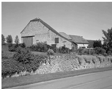
Vue générale depuis la route. Phot. Thierry Lefébure IVR22_20010201799V
