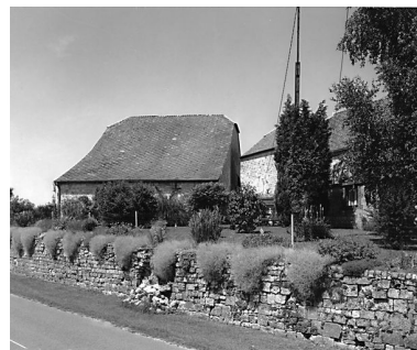
Vue générale depuis la route. Phot. Thierry Lefébure IVR22_20010201800V
