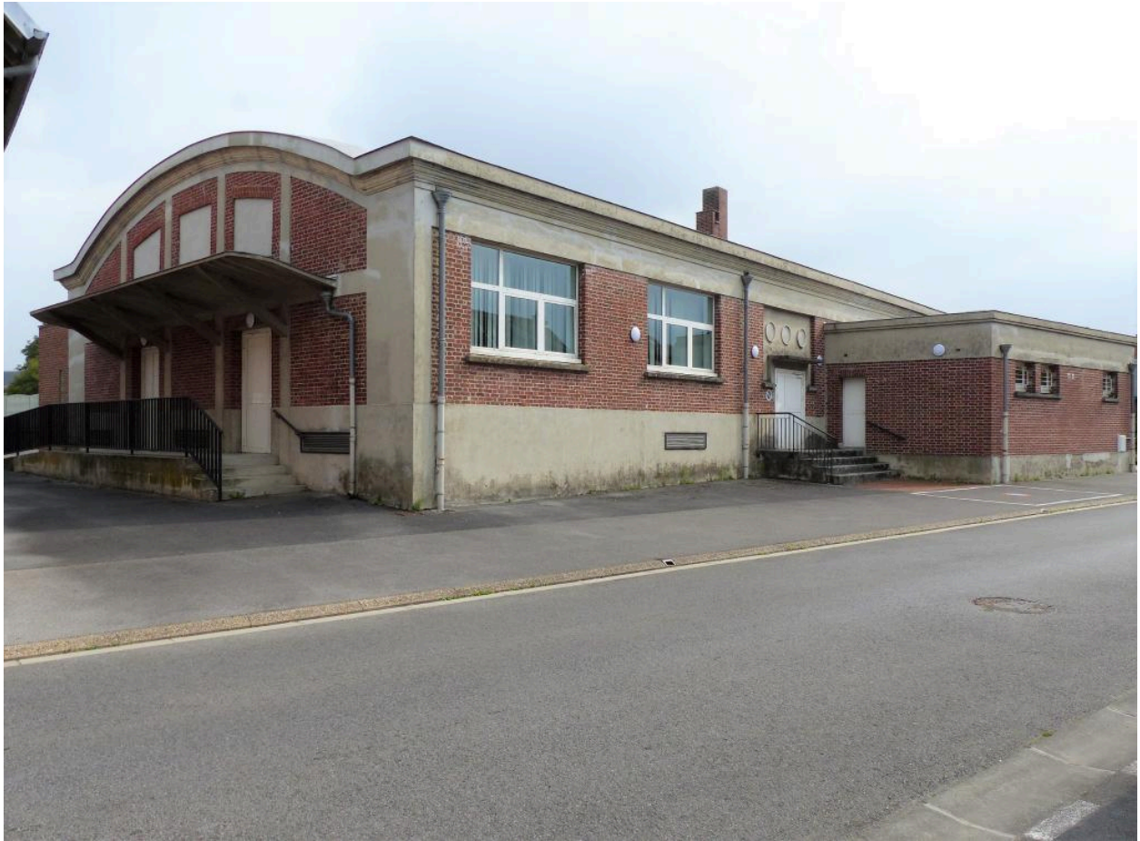
Vue générale, depuis la rue Fernand-Bouyssou.
