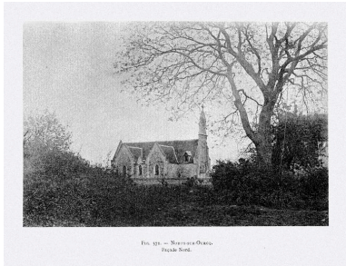
Photographie de l'élévation nord de l'église, prise par Étienne Moreau-Nélaton en 1913 (Les Églises de chez nous. Arrondissement de Soissons. T. 2, fig. 571). Phot. Thierry Lefébure IVR22_19950202353ZB
