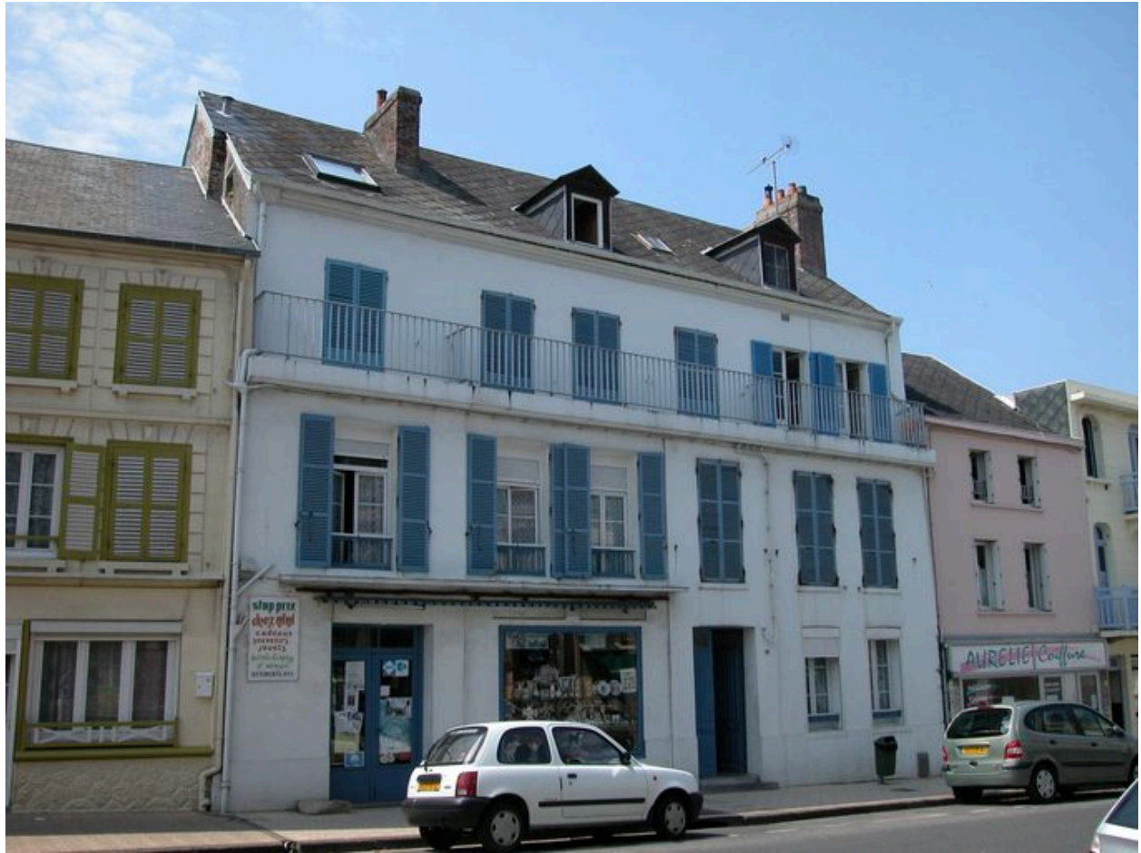
Ancienne annexe de l'Hôtel de France, 30 Grande-Rue.
