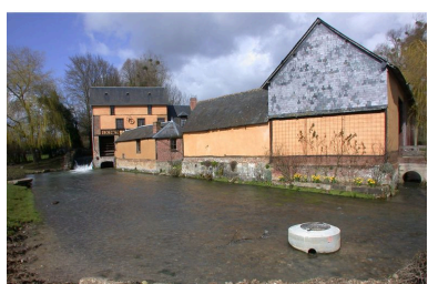
Vue d'ensemble extérieur du moulin Vertu.
