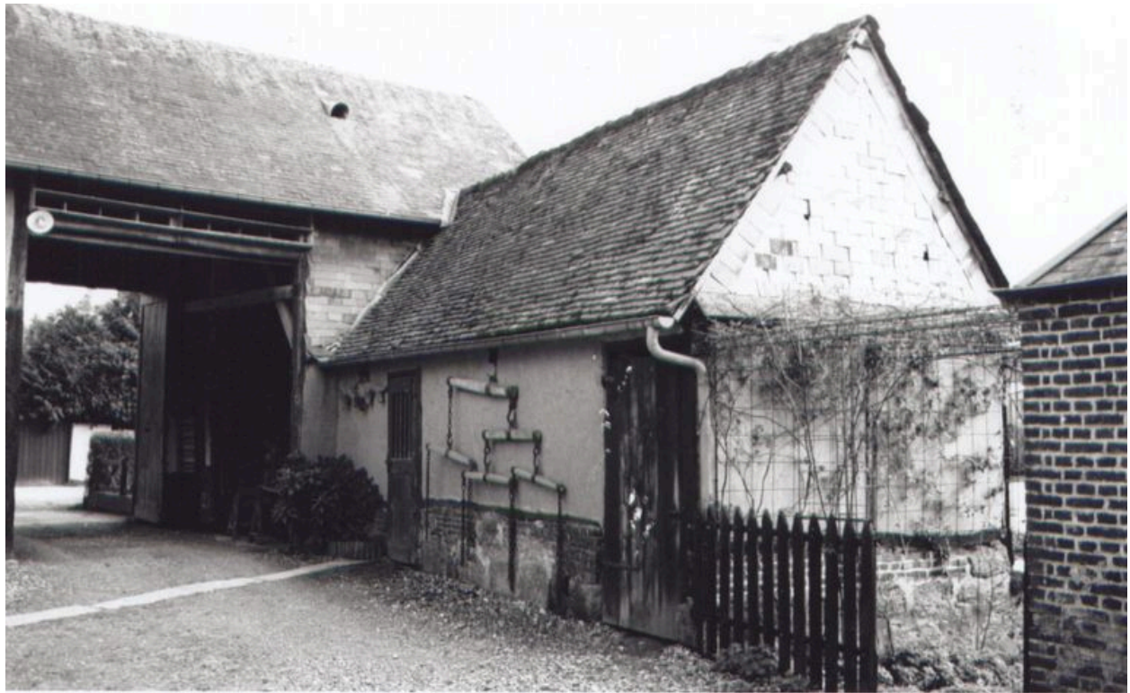
L'entrée charretière sous porche, façade sur cour.
