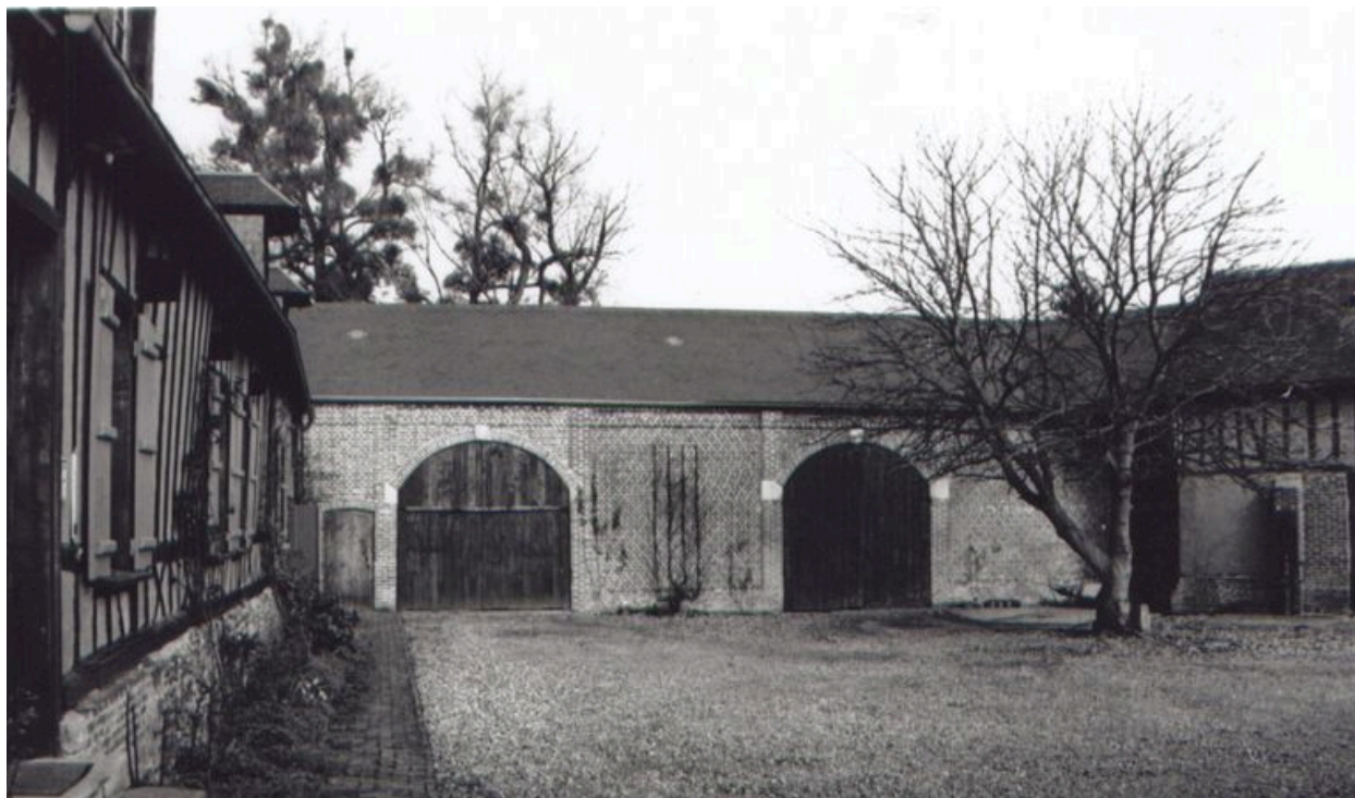
Les granges, façade sur cour.
