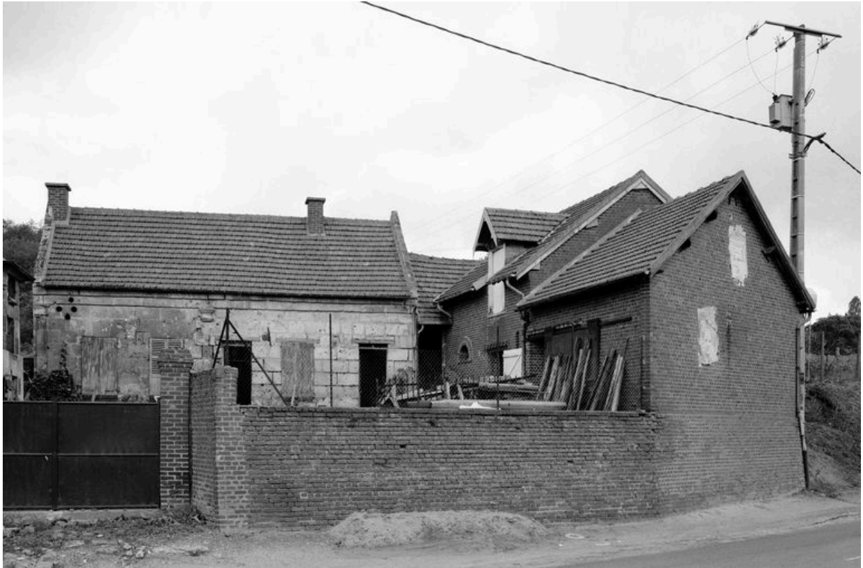
Vue générale sur rue.
