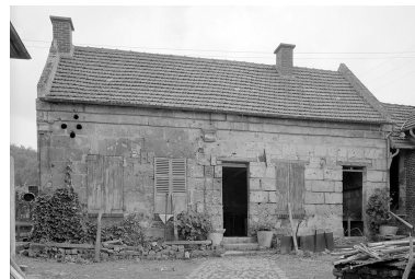
Logis. Elévation antérieure. Phot. Jean-Michel Perrin IVR22_19856000973X
