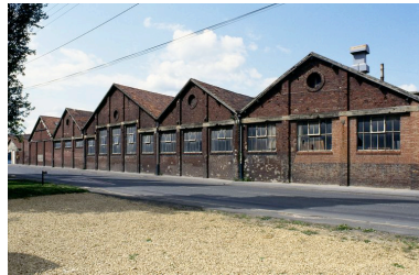
Succession des façades des ateliers d'entretien et des magasins d'approvisionnement le long de la rue Louis-Pasteur (détruits). Phot. Benoît Dufournier IVR22_19926000040ZA
