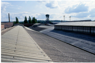
Toitures des ateliers de la Cerabati, 1992. Phot. Benoît Dufournier IVR22_19926000048ZA
