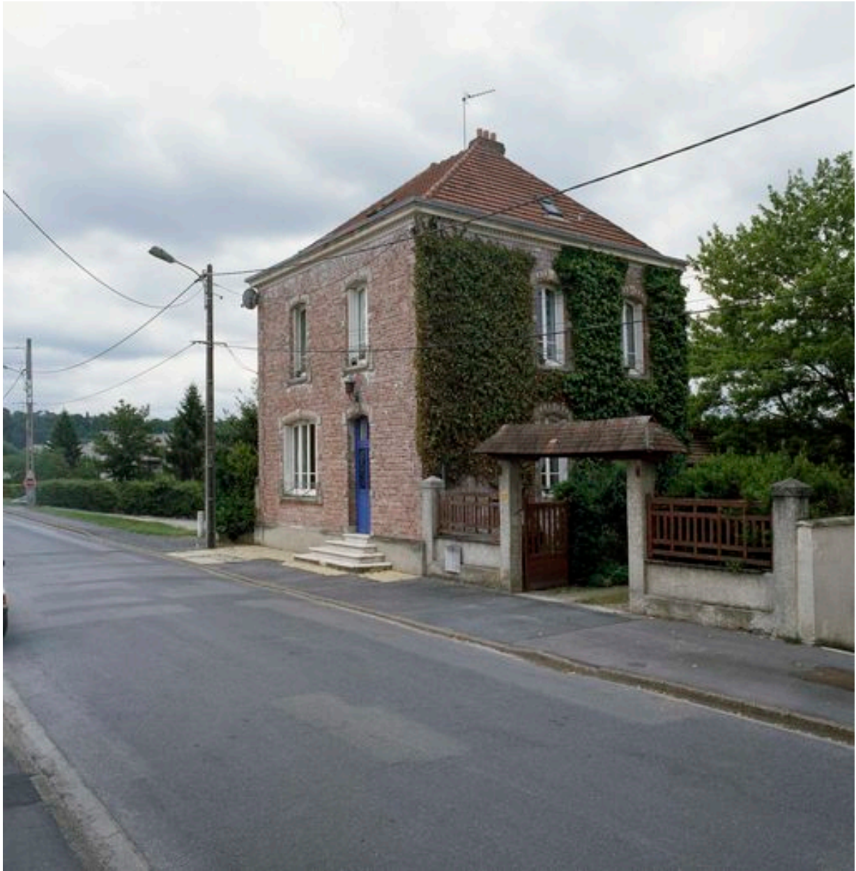
Logement d'ingénieur de la Cerabati (rue Léon-Bourgeois), construit en 1929.
