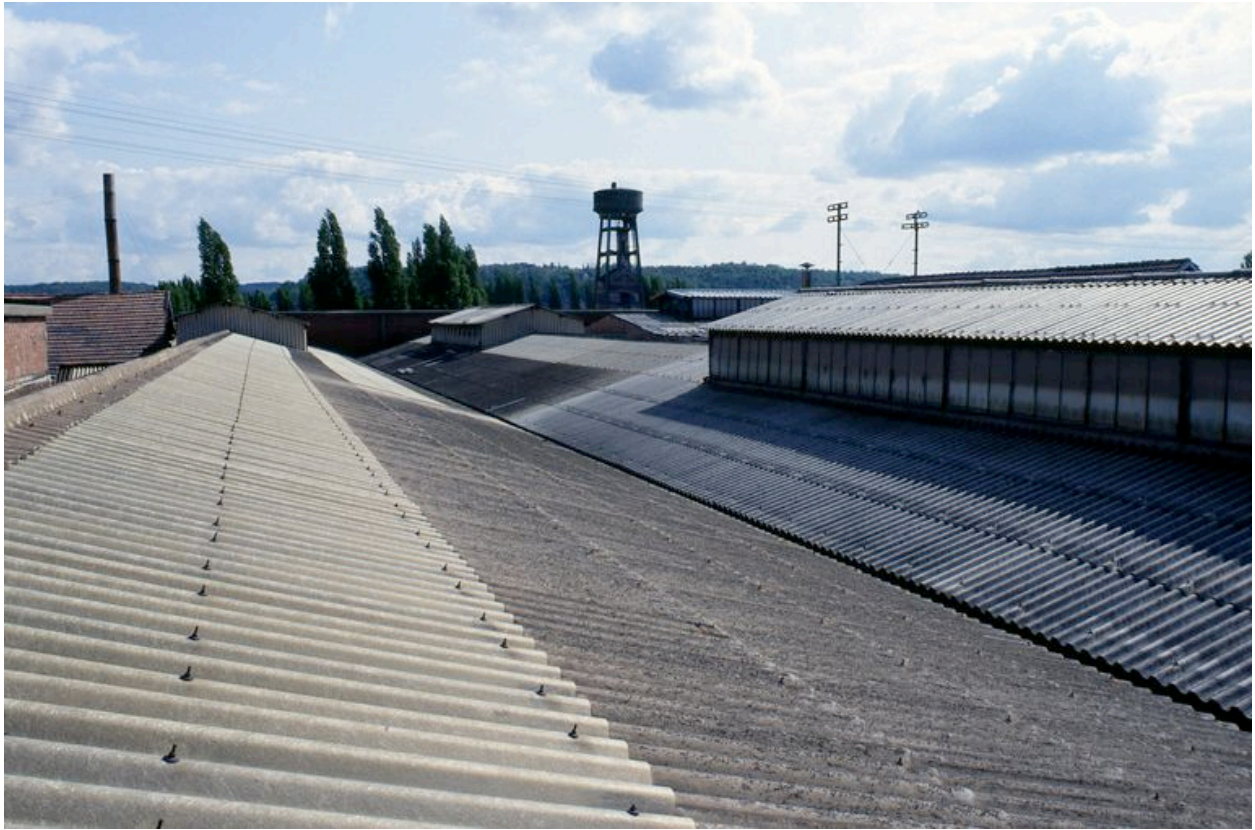
Toitures des ateliers de la Cerabati, 1992.
