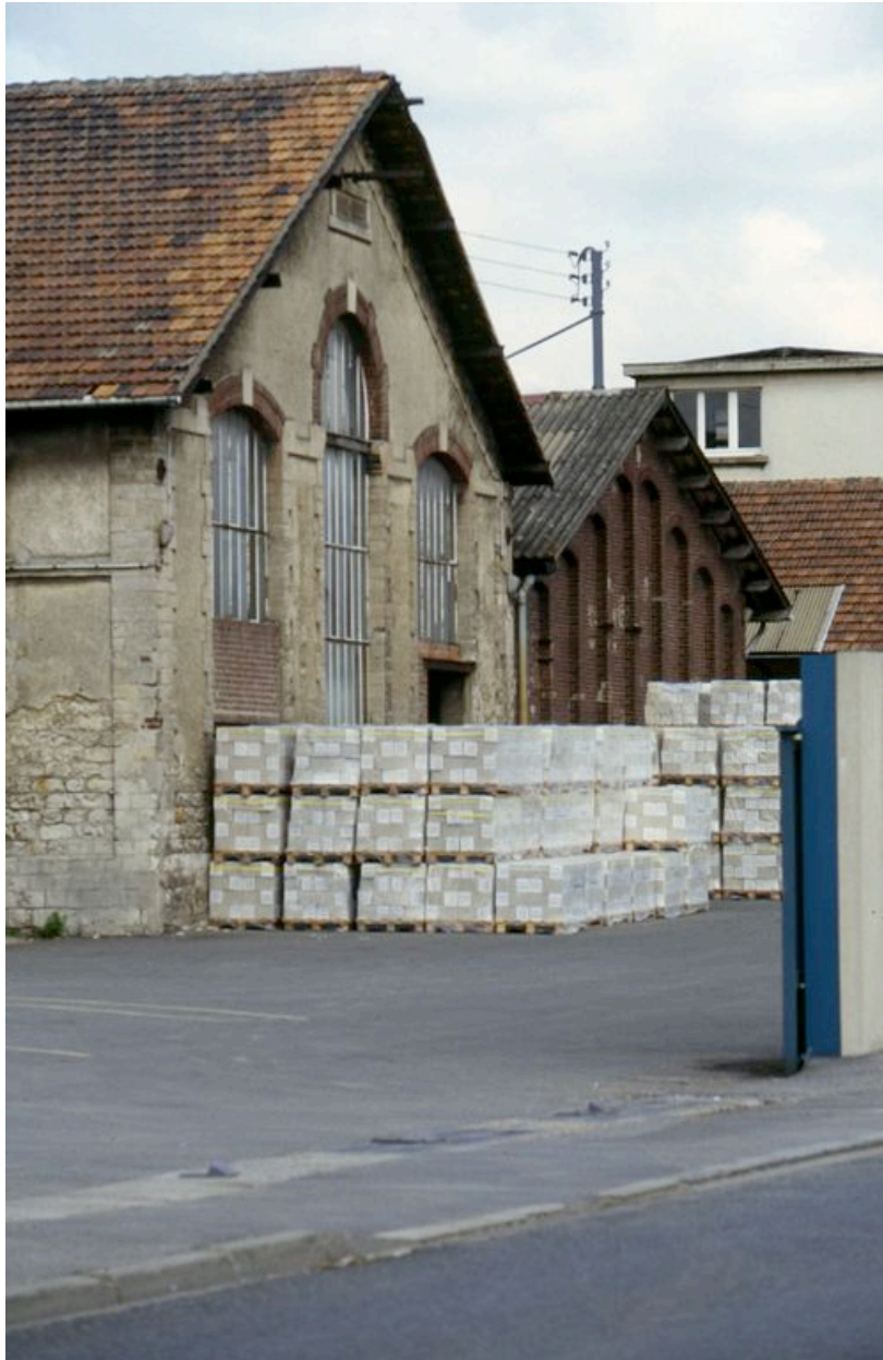
Magasins de stockage et palettes de carrelages prêts à être expédiés, 1992.
