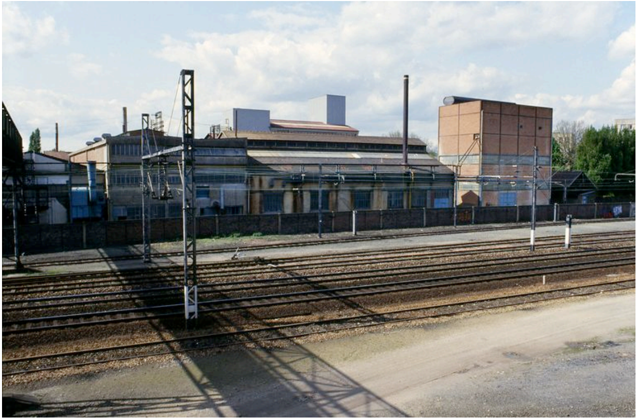
Vue des bâtiments de la Cerabati depuis les voies ferrées, 1992.
