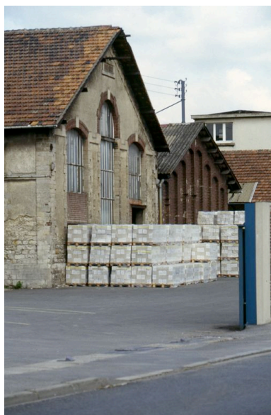
Magasins de stockage et palettes de carrelages prêts à être expédiés, 1992.
