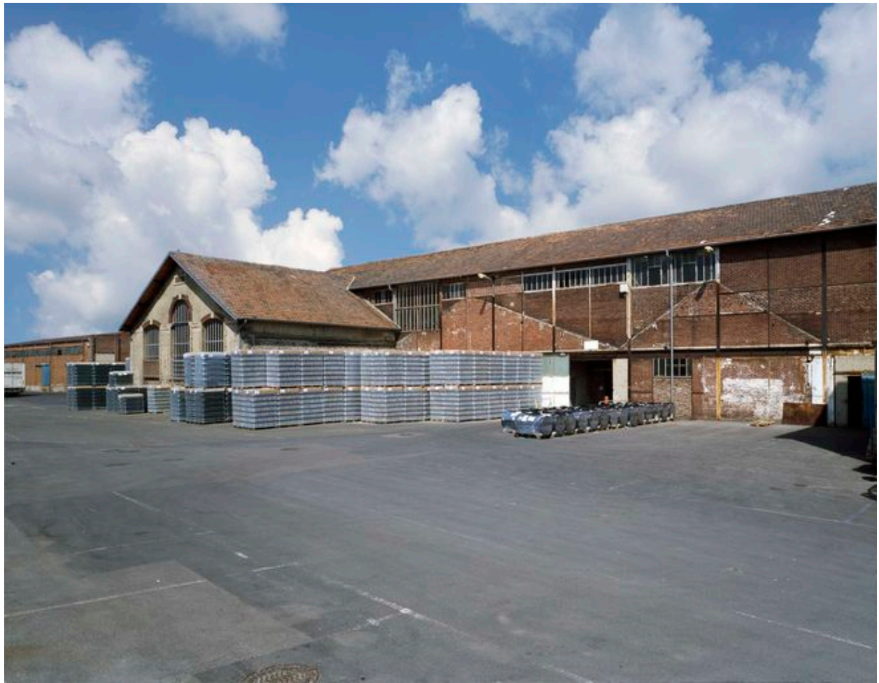
Anciens ateliers de fabrication de la Cerabati utilisés par Saga Décor et traces de démolition de certains ateliers.
