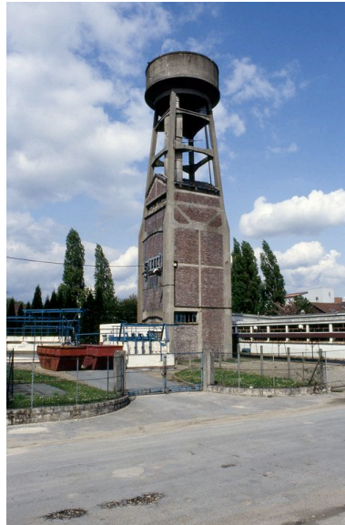
Château d'eau situé face à l'usine (détruit). Phot. Benoît Dufournier IVR22_19926000043ZA
