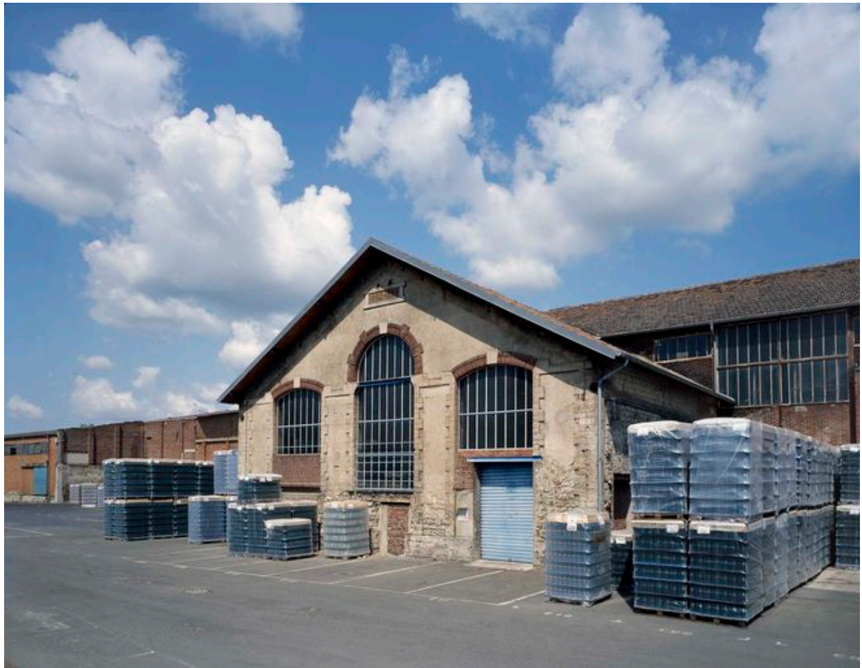
Atelier de fabrication datant de la première tranche de construction (1882-1899) et conservé.
