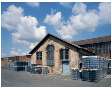
Atelier de fabrication datant de la première tranche de construction (1882-1899) et conservé. Phot. Thierry Lefébure IVR22_20106000304VA
