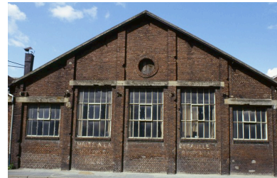
Détail de la façade d'un atelier détruit. Phot. Benoît Dufournier IVR22_19926000041ZA
