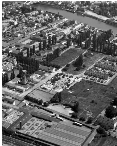
L'ancienne usine Cerabati vue vers le sud, 1995. Phot. Sanson Aviation IVR22_19956000879X
