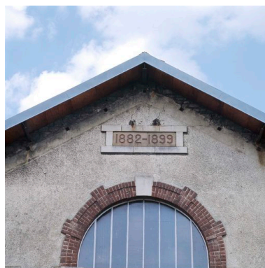
Détail de la date portée sur l'atelier. Phot. Thierry Lefébure IVR22_20106000309XA
