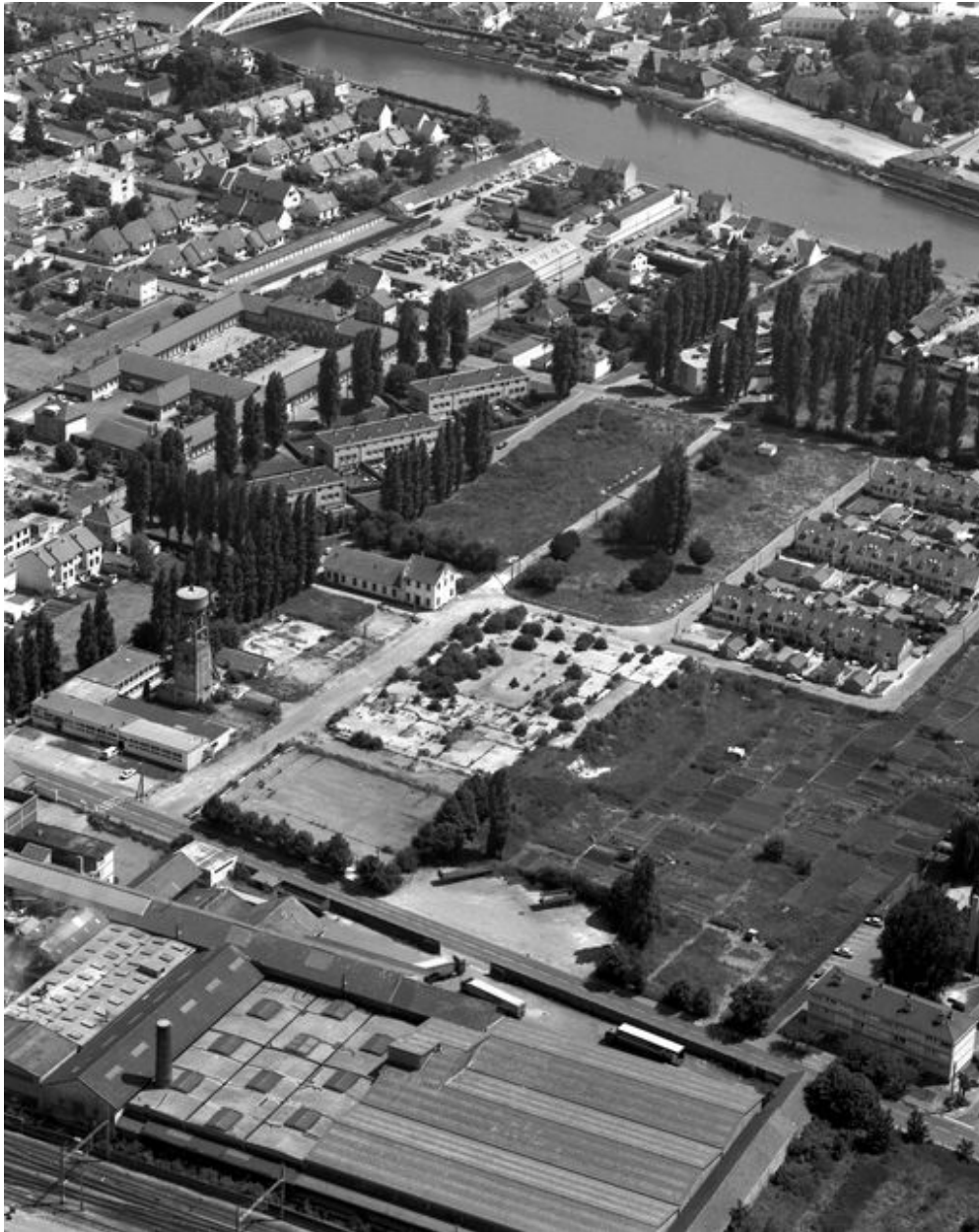
L'ancienne usine Cerabati vue vers le sud, 1995.
