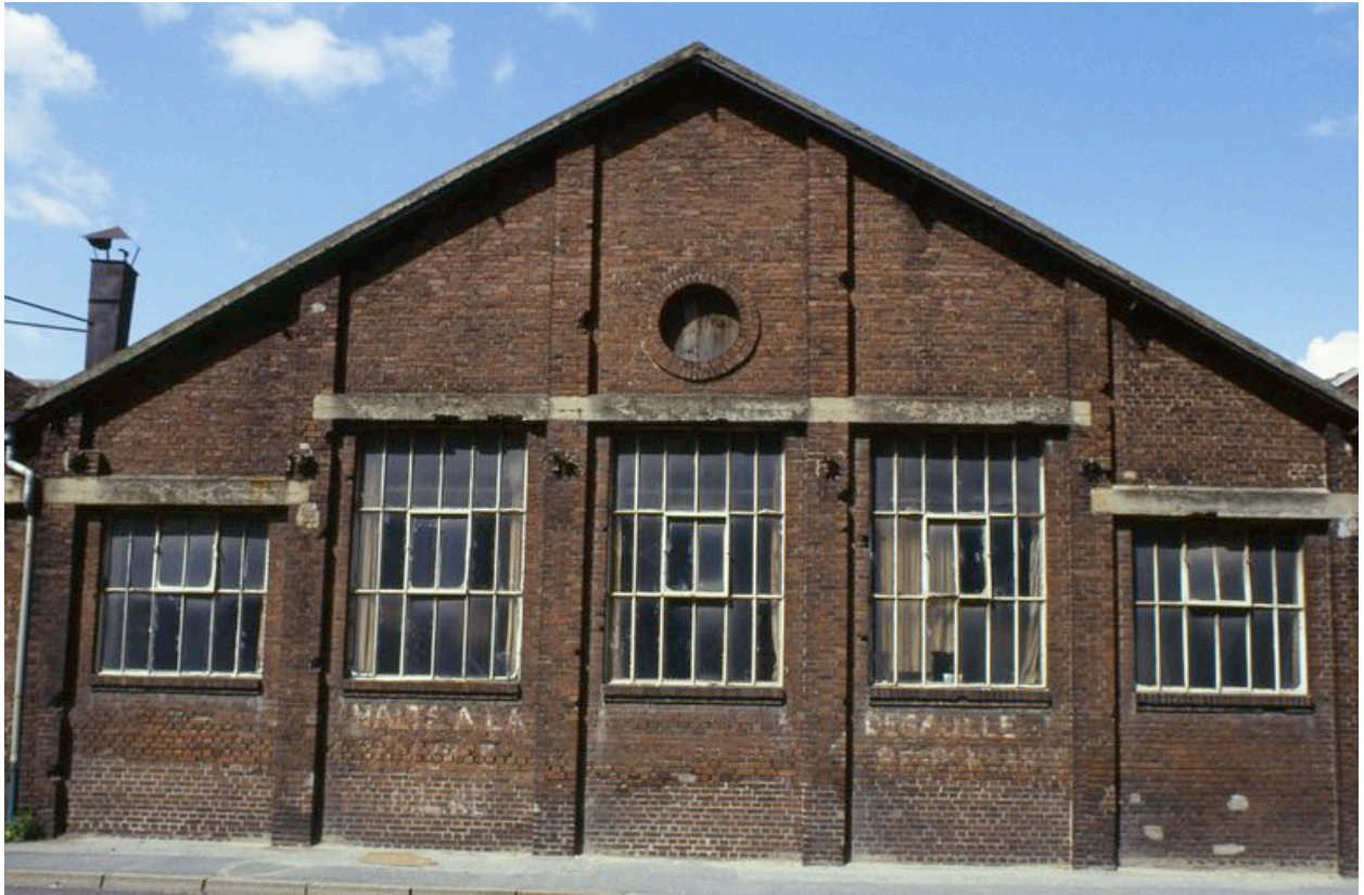
Détail de la façade d'un atelier détruit.
