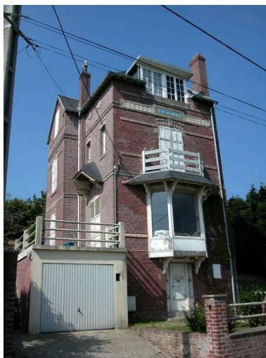
Vue d'ensemble depuis la rue. Phot. Elisabeth Justome IVR22_20048001635NUCA
