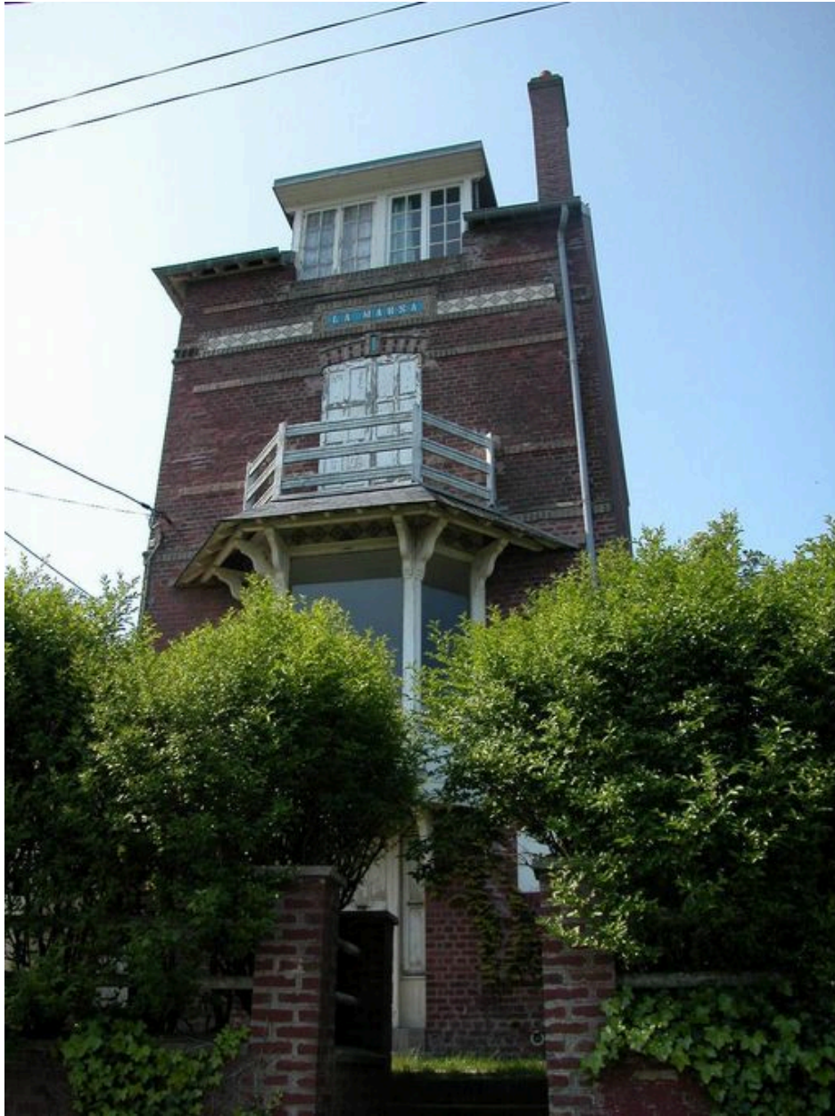
Détail de la travée en façade, avec le bow-window surmonté d'un balcon.
