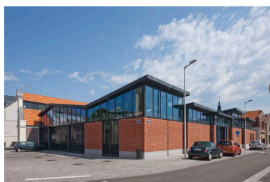
Vue générale depuis la rue des halles. Phot. Hubert Bouvet IVR31_20136200238NUCA
