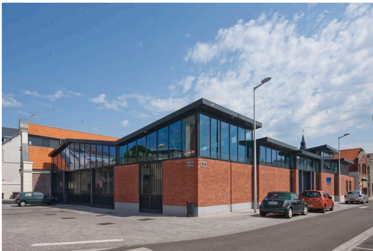
Vue générale depuis la rue des halles.
