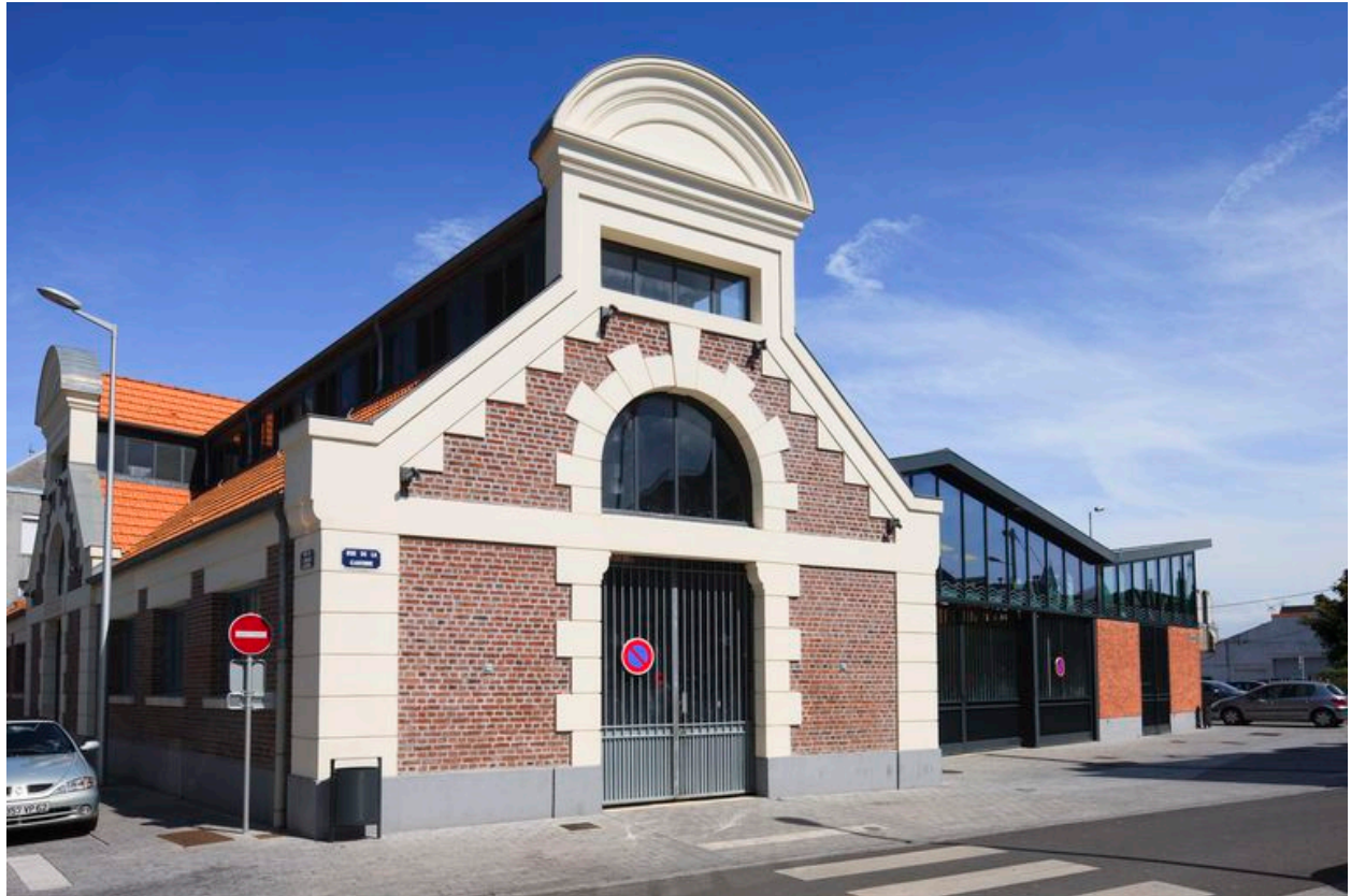
Vue générale de l'entrée ouest.
