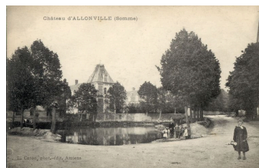
Château d'Allonville (Somme) [vue de situation depuis le sud-ouest], carte postale, L. Caron phot. et édit., 1er quart 20e siècle (AD Somme ; collection particulière) Phot. Archives départementales de la Somme IVR22_20038010287NUCA
