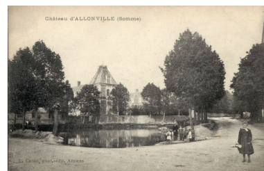
Château d'Allonville (Somme) [vue de situation depuis le sud- ouest], carte postale, L. Caron phot. et édit., 1er quart 20e siècle (AD Somme ; collection particulière) Phot. Archives départementales de la Somme IVR22_20038010287NUCA
