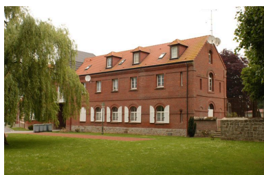
Anciennes dépendances du château : corps est, vu depuis le sud-est. Phot. Thierry Lefébure
