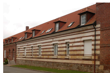
Anciennes dépendances du château : corps central côté rue. Phot. Thierry Lefébure
