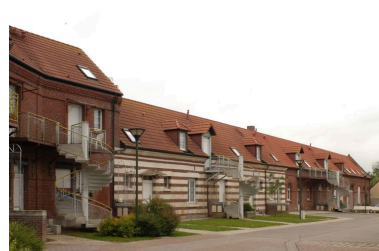
Anciennes dépendances du château : côté cour. Phot. Thierry Lefébure IVR22_20038000454NUCA
