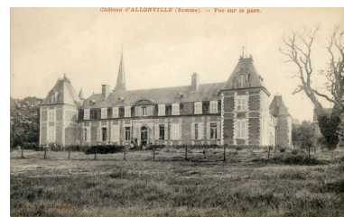
Château d'Allonville (Somme). Vue sur le parc, carte postale, édit. Veuve Delacheux, 1er quart 20e siècle (AD Somme ; collection particulière). Phot. Archives départementales de la Somme IVR22_20038010293NUCA
