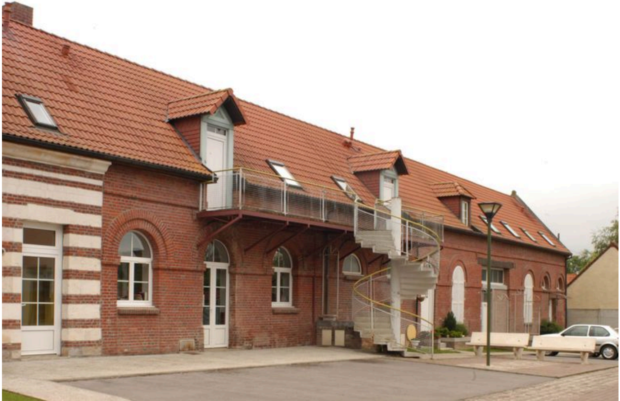
Anciennes dépendances du château : corps latéral ouest côté cour.
