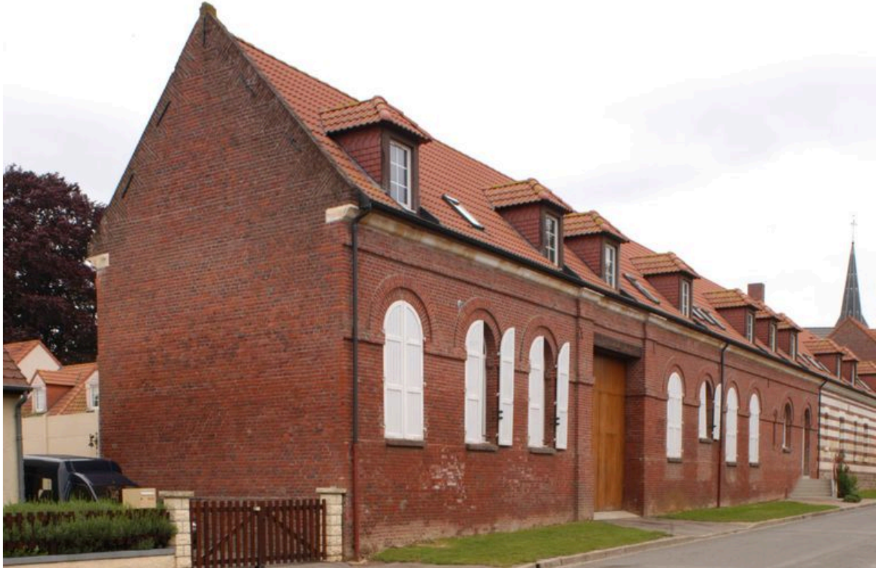
Anciennes dépendances du château : corps latéral ouest, côté rue.
