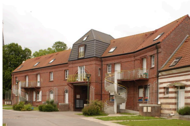
Anciennes dépendances du château : corps est, côté cour. Phot. Thierry Lefébure IVR22_20038000457NUCA
