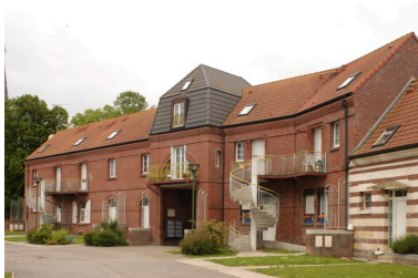
Anciennes dépendances du château : corps est, côté cour. Phot. Thierry Lefébure IVR22_20038000457NUCA
