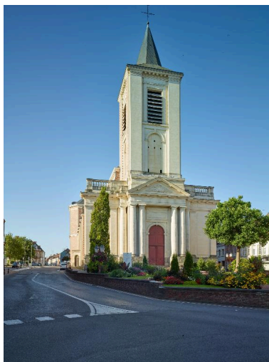
Vue générale de trois quarts depuis la place de l'église. Phot. Pierre Thibaut IVR31_20155901386NUCA
