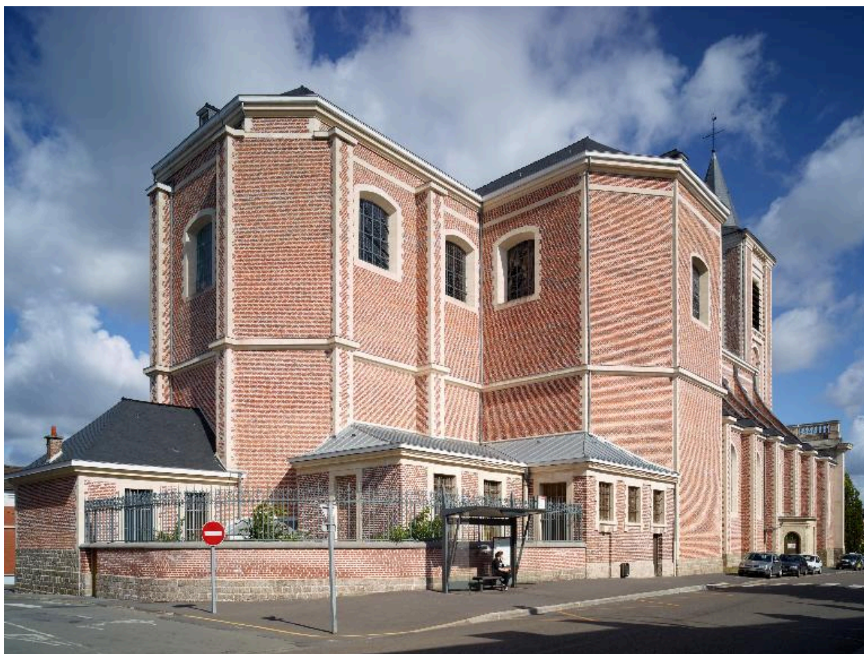
Vue générale extérieure depuis l'abside.
