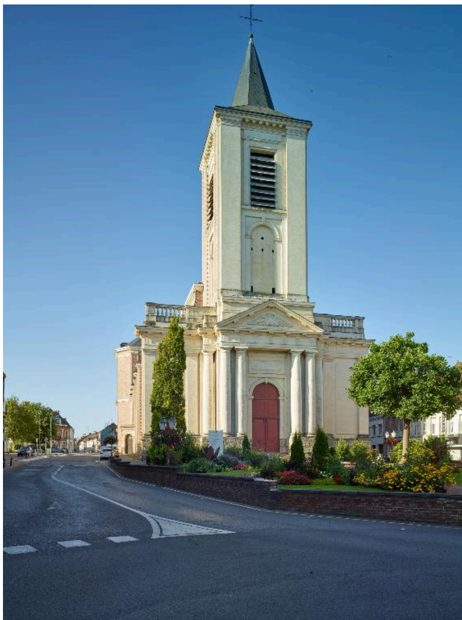
Vue générale de trois quarts depuis la place de l'église.
