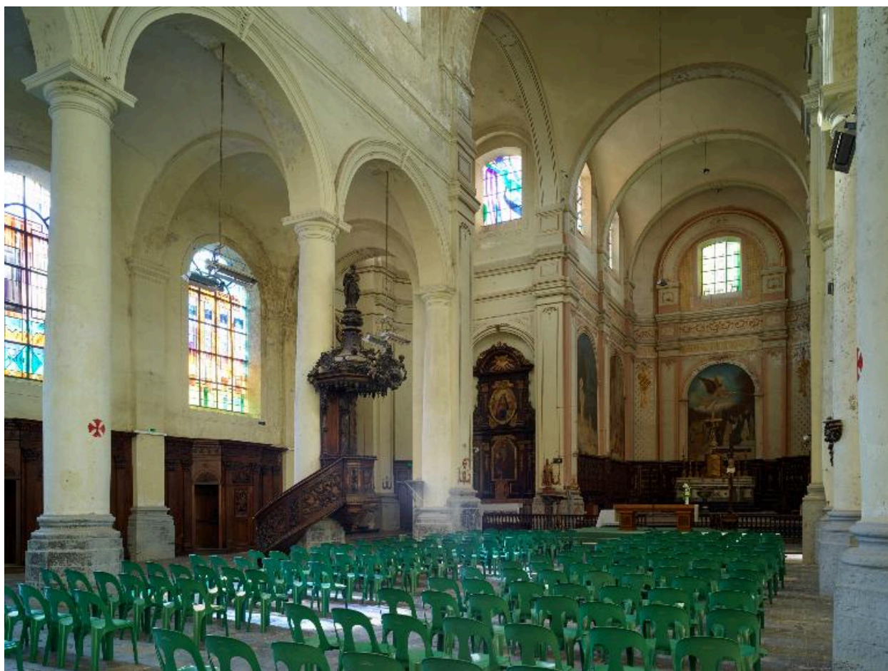
Vue générale de trois quarts des grandes arcades de la nef, le transept non saillant et le chœur à chevet plat.
