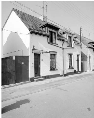
Cité ouvrière, détail sur un logement. Phot. Thierry Lefébure IVR22_19898000368X
