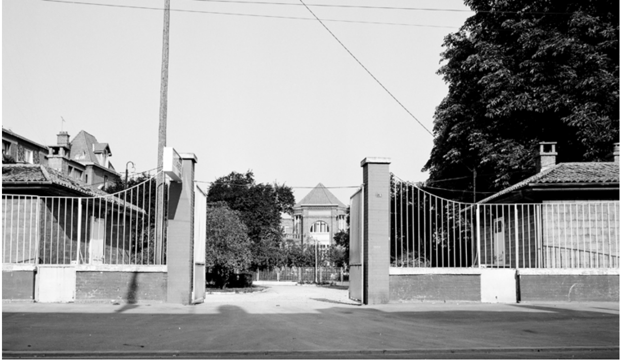
Entrée de l'établissement.
