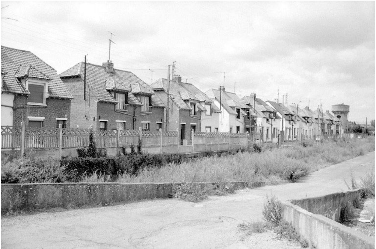
Cité ouvrière, les Bleuets.
