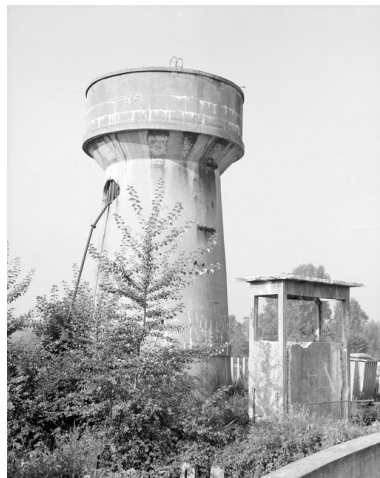
Château d'eau. Phot. Thierry Lefébure IVR22_19898000367X
