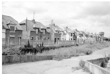
Cité ouvrière, les Bleuets. Phot. Benoît Dufournier IVR22_19878000135Z
