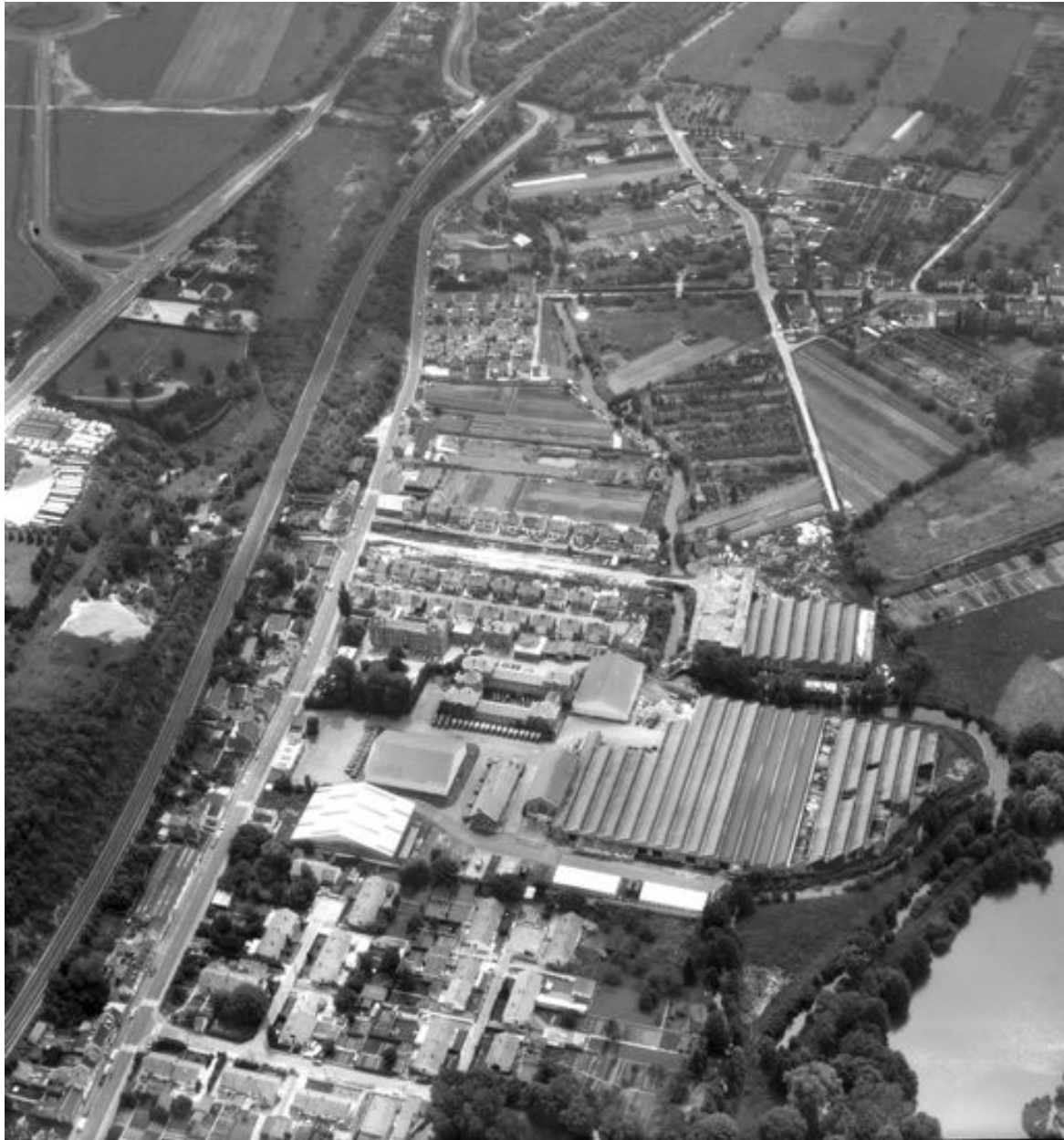
Vue aérienne, flanc sud.
