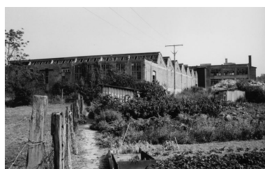
Atelier de fabrication (tissage), flanc sud-ouest. Phot. Thierry Lefébure IVR22_19898000364X
