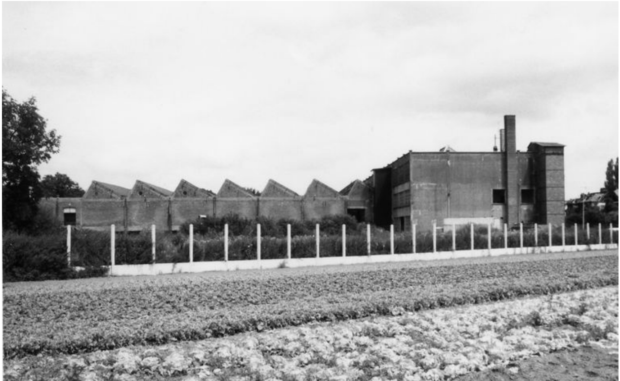
Atelier de fabrication (tissage), flanc sud.
