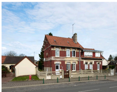
Les logements des institutrices depuis la rue Jean-Jaurès. Phot. Thierry Lefébure IVR22_20138000118NUC2A
