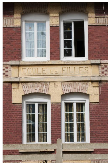
Détails de l'élévation principale du logements des institutrices. Phot. Thierry Lefébure IVR22_20138000119NUC2A
