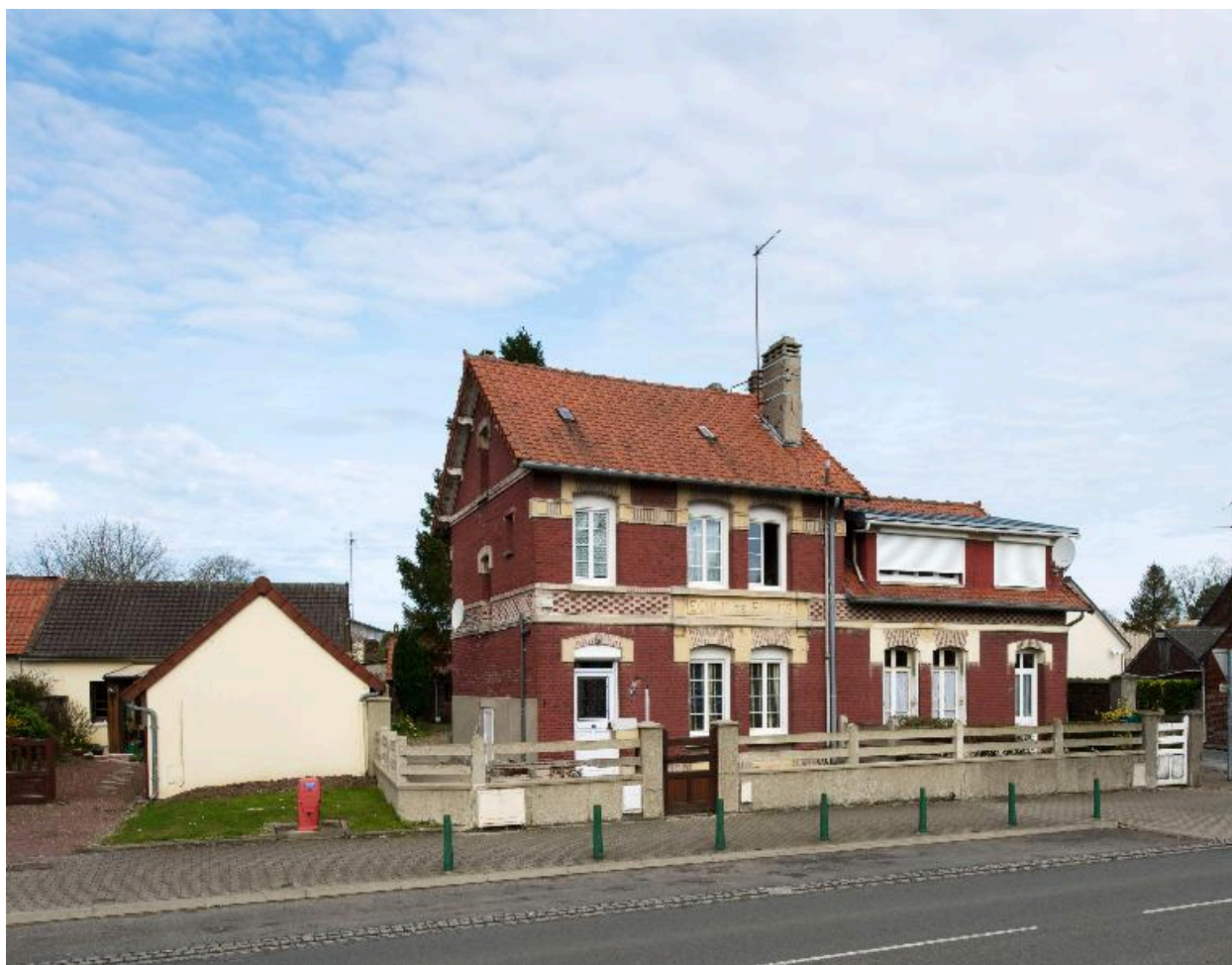
Les logements des institutrices depuis la rue Jean-Jaurès.
