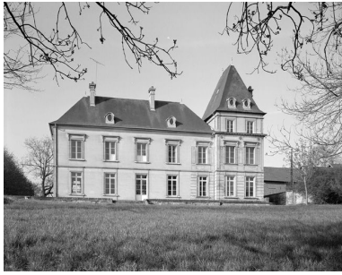
Elévation postérieure. Phot. Jean-Michel Perrin IVR22_19856000553V
