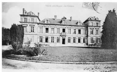
Façade avant 1914 (AP). Phot. Jean-Michel Périn IVR22_19856000252XB
