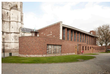
Vue générale avec le baptistère au premier plan. Phot. Hubert Bouvet IVR31_20106200621NUCA
