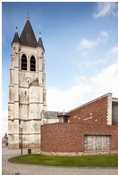
Vue du clocher. Phot. Hubert Bouvet IVR31_20106200620NUCA
