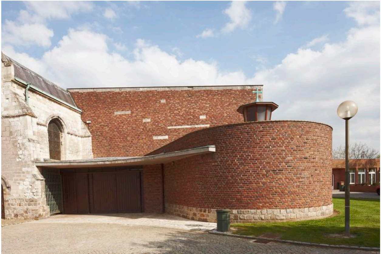
Détail de l'entrée et du baptistère.
