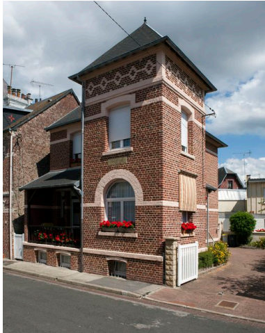
Vue générale. Phot. Pierre Thibaut IVR31_20146202203NUCA
