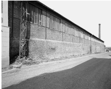
Atelier de fabrication, élévation antérieure.
