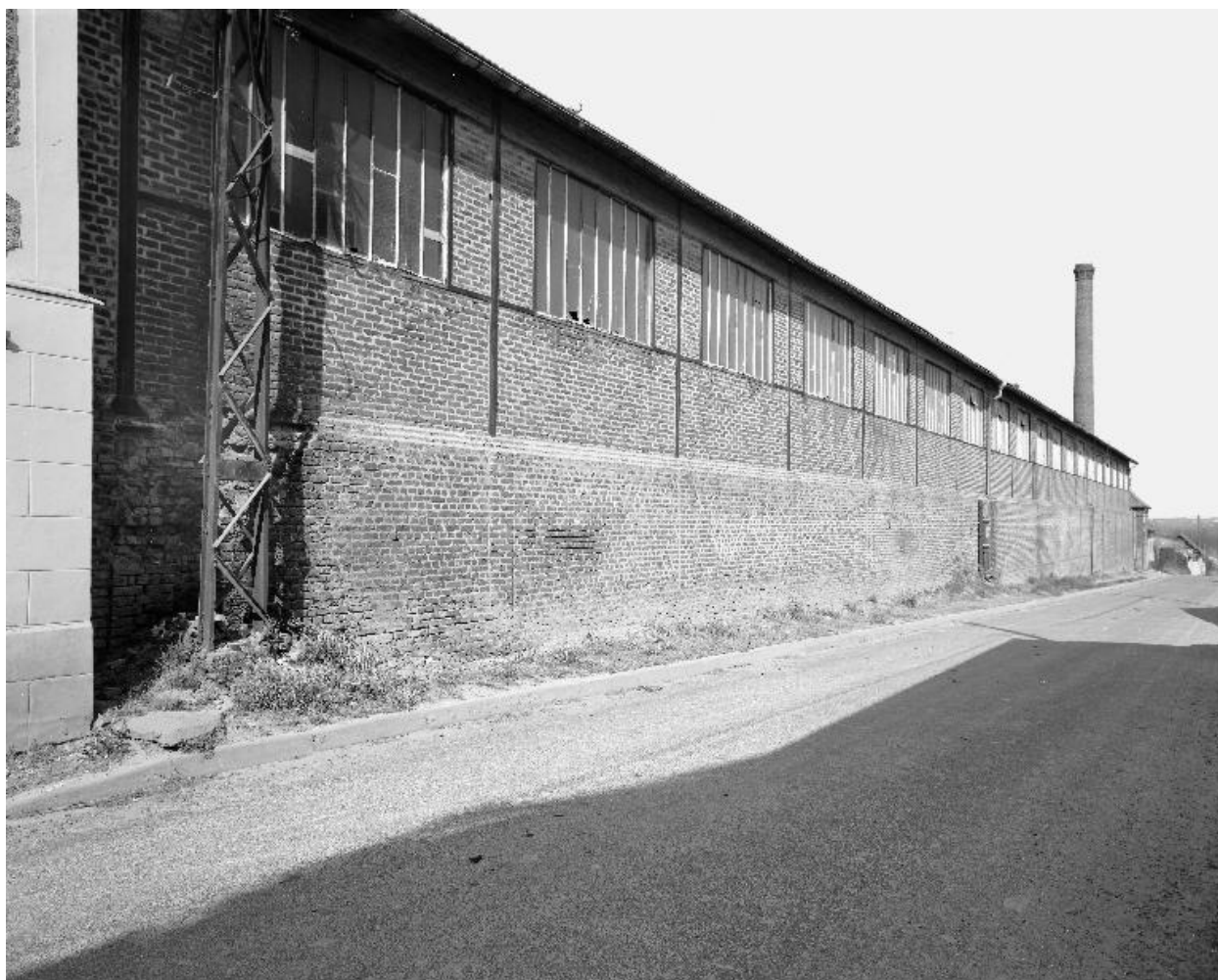
Atelier de fabrication, élévation antérieure.
