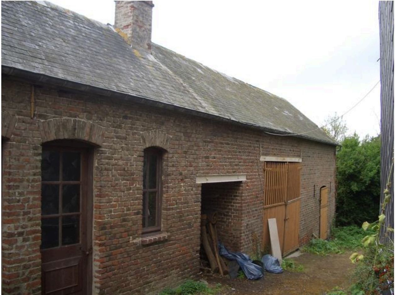
Détail de la façade.
