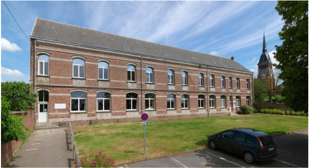
Vue générale, depuis le sud-ouest.
